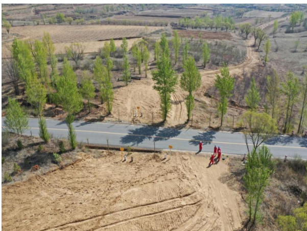
管线顶管穿越沥青路
