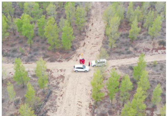
管线大开挖穿越土路
