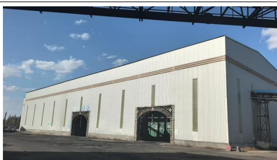
新建原煤和中煤储棚
