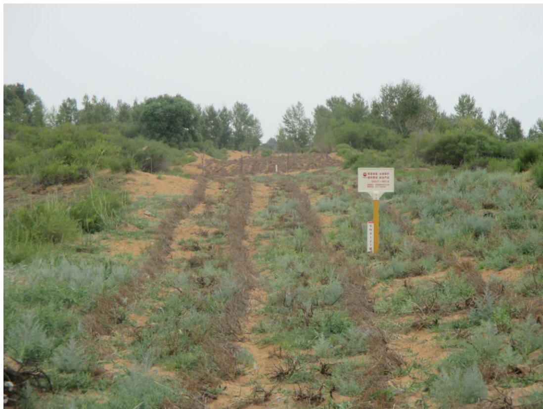
C127 管线植被恢复情况
