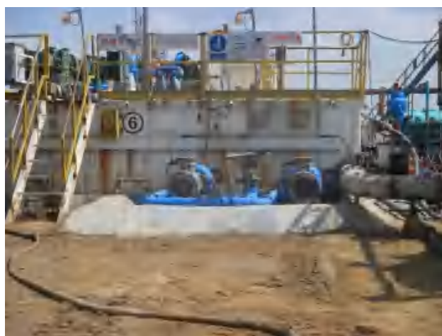
配料口建立料台，底部做好防渗。
