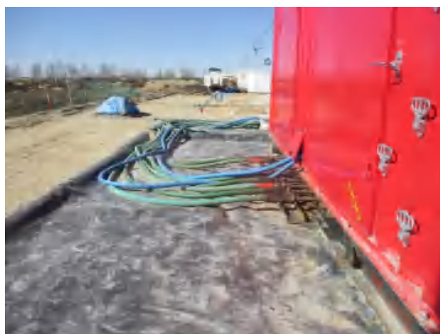
远控房底部四周建立有效围堰，铺设防渗膜。
