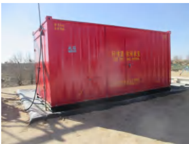
远控房底部四周建立有效围堰，铺设防渗膜。
