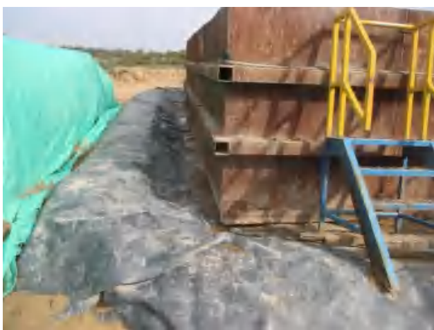
泥浆罐区底部四周建立 0.5m 高围堰，铺设 2 层防渗膜。
