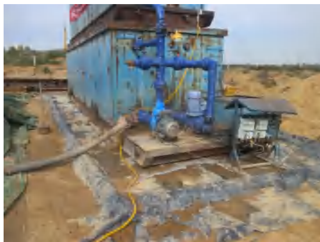
水罐区底部铺设防渗膜。
