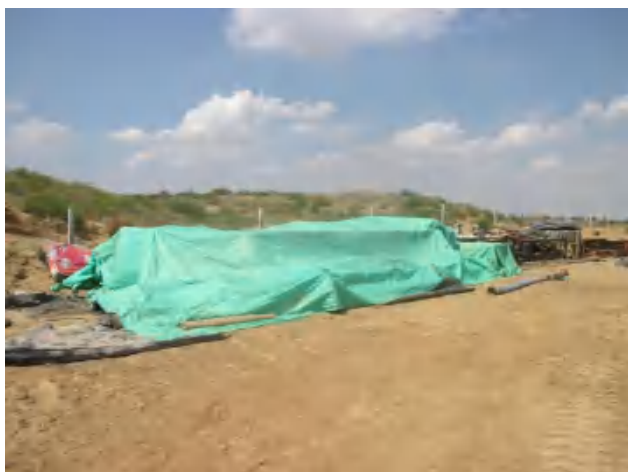
备用设备底部铺设防渗膜，上方及时苫盖。
