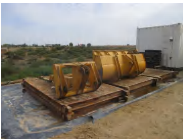
装载区底部四周建立有效围堰，铺设防渗膜。
