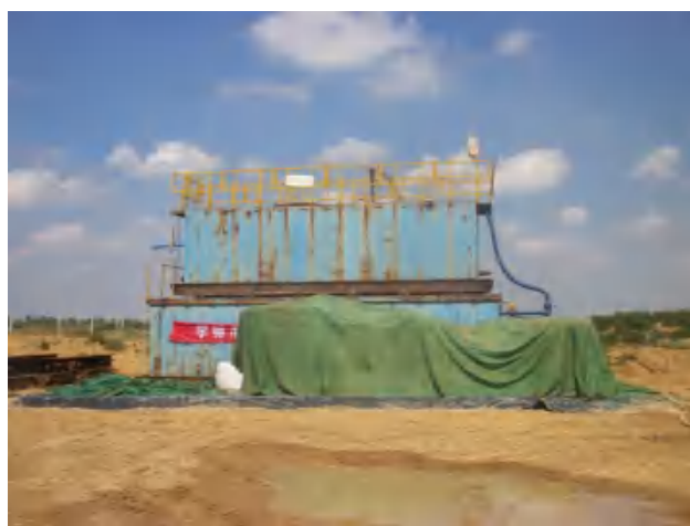
化工料区化工料区底部建立料台，铺好防渗膜，上方及时苫盖。
