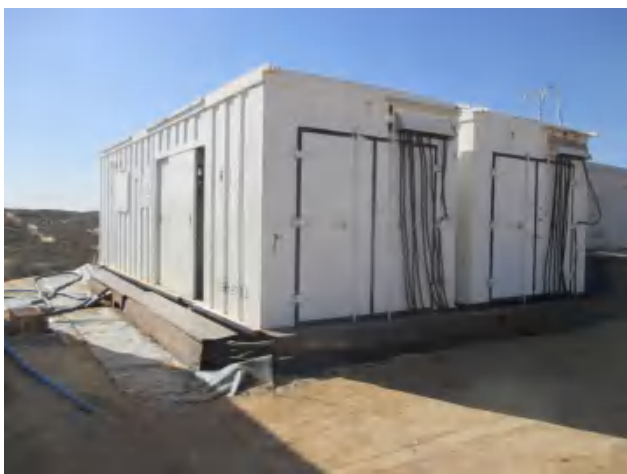
配电区底部四周建立有效围堰，铺设防渗膜。
