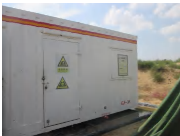
设立危废暂存间底部建立有效围堰，铺防 渗膜，危废交有资质单位处理。
