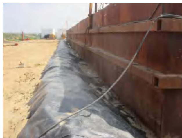
泥浆罐区底部四周建立 0.5m 高围堰，铺设 2 层防渗膜。
