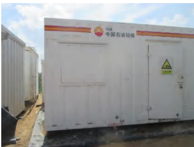
设立工业垃圾暂存间底部建立有效围堰， 铺防渗膜。
