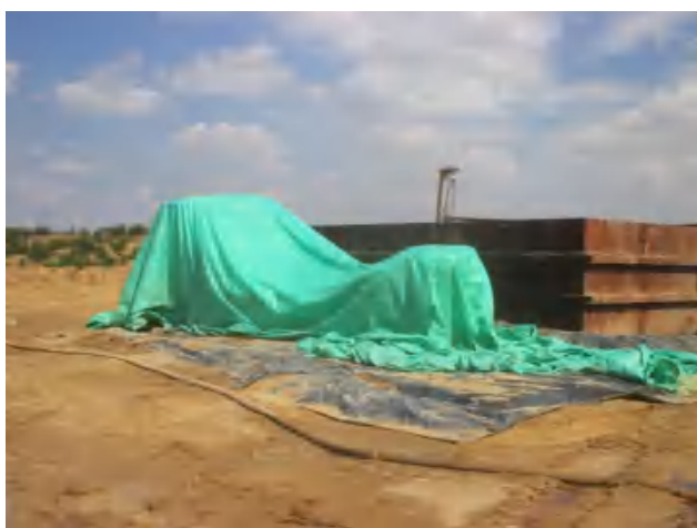
化工料区化工料区底部建立料台，铺好防渗膜，上方及时苫盖。
