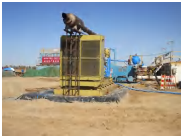
备用设备区底部建立有效围堰，铺设防渗膜。
