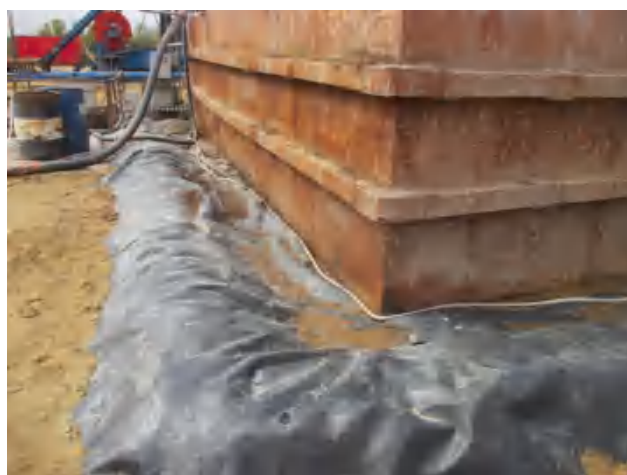
循环罐区底部建立有效围堰，铺设防渗膜。
