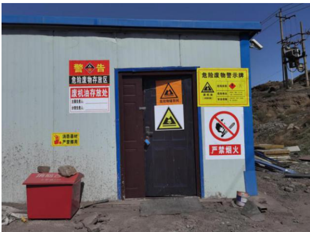
危废库房外部
