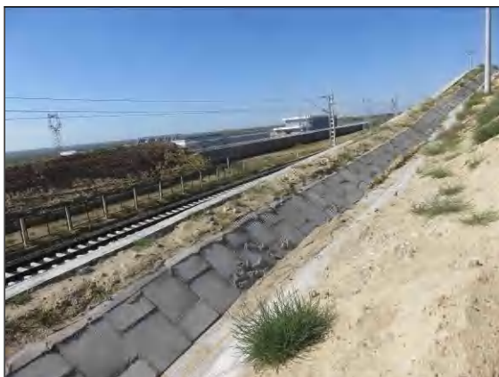
路基两侧天沟
