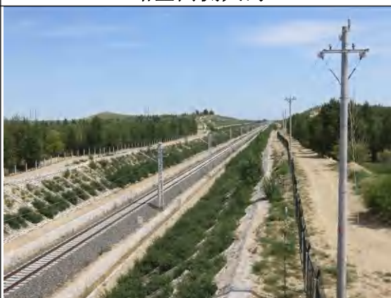
路基两侧侧沟
