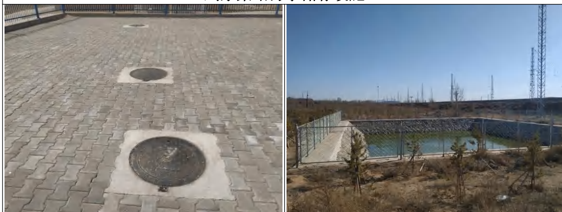
泊江海站污水储存设施
