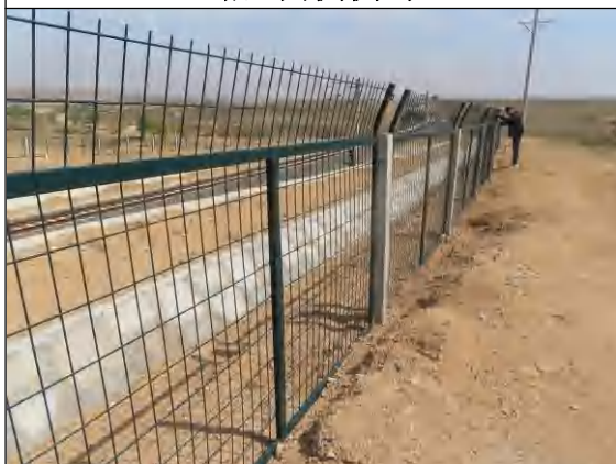
路基两侧排水沟
