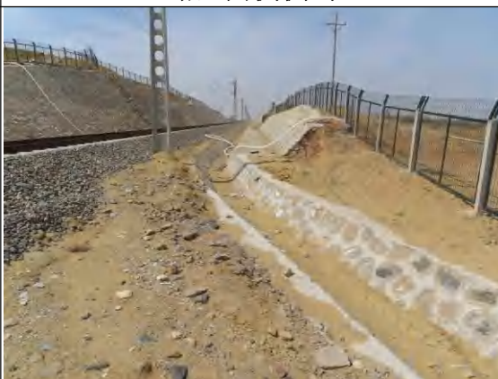
路基两侧排水沟
