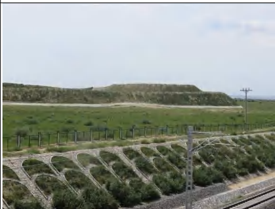
路基两侧拱形骨架护坡
