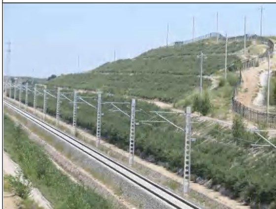
路基两侧拱形骨架护坡
