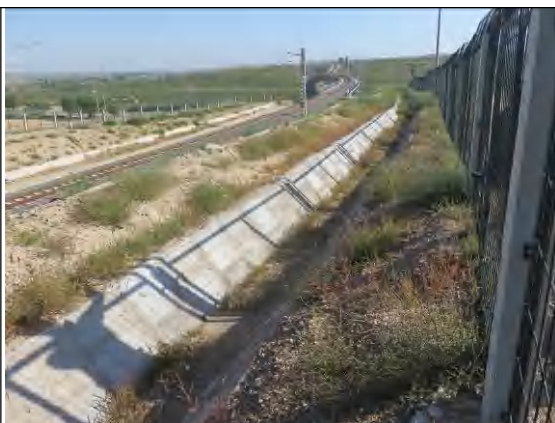
路基两侧天沟
