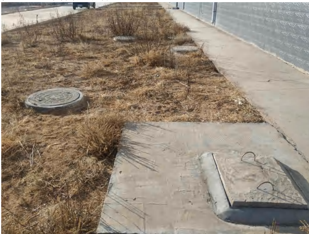
泊江海站污水储存设施
