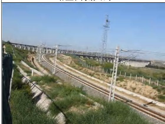
路基两侧侧沟
