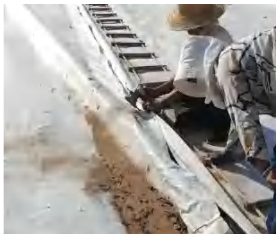
复合土工膜采用双轨焊机焊接
