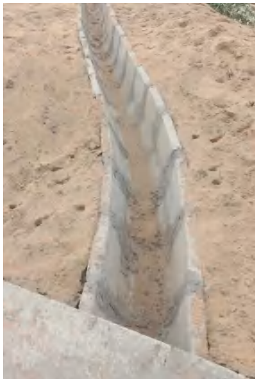
渗滤液导流槽
