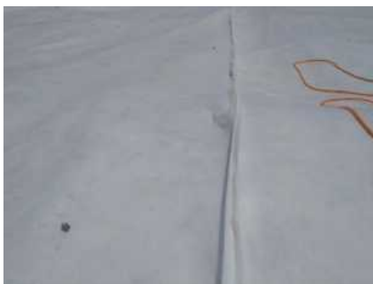
土工布采用缝包机缝合
