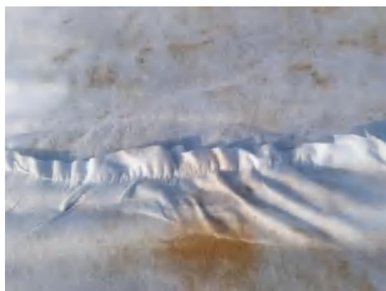
复合土工膜上方土工布缝合
