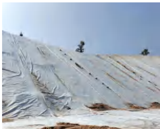
边坡土工布上方使用沙袋固定
