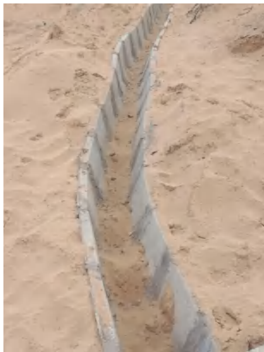
渗滤液导流槽
