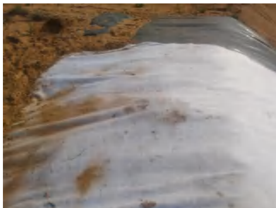
1.5mm 厚土工膜上方铺设复合土工膜
