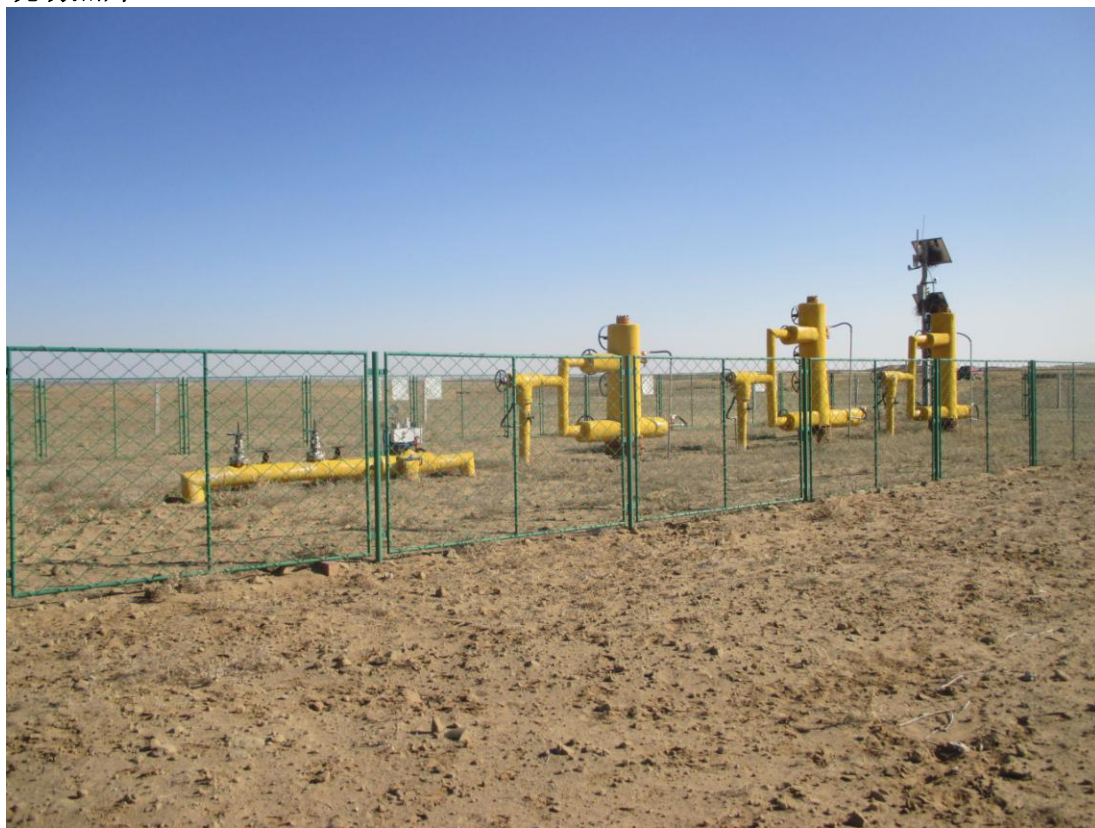
苏 75-63-32 井场植被恢复情况
