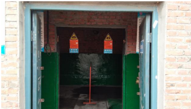
1#危废暂存库内部
