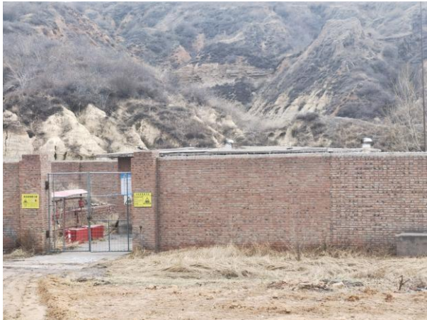
危废暂存库区外墙
