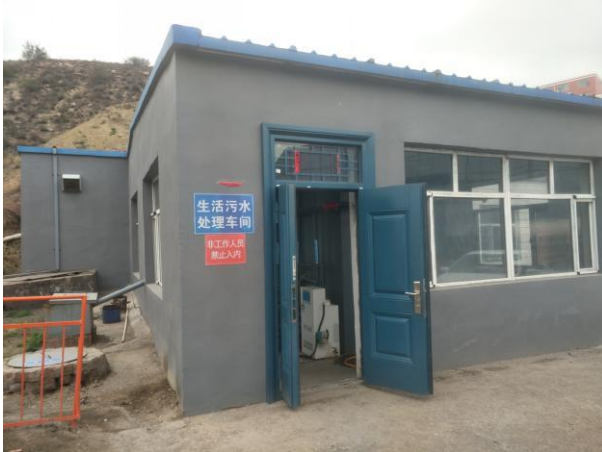
污水处理设施
