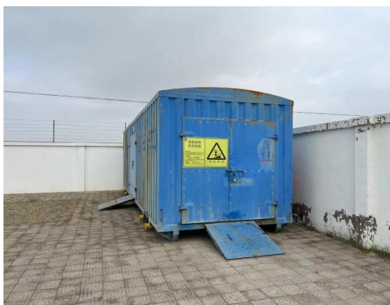
危废暂存库房外部
