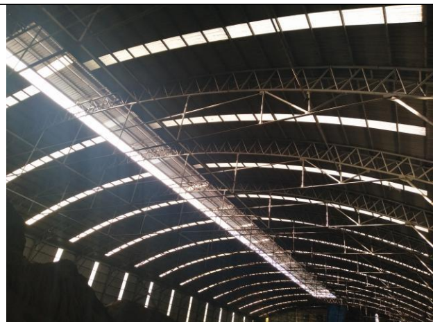
储煤棚顶部安装有喷淋设施
