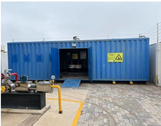
危废暂存库房外部
