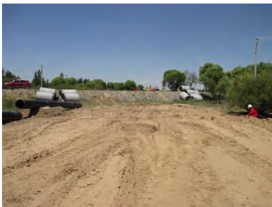
顶管穿越路段
