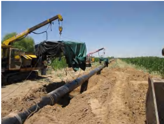
管线施工采用低噪声设备
