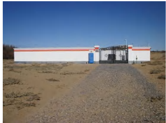
二处调气管线阀室投入运行
