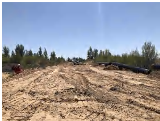
管线施工扫线
