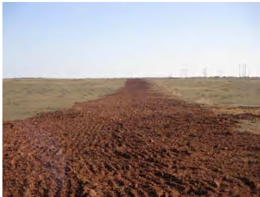
管线施工不设置弃土场、土壤全部用于管线沿线坑洼处平整使用
