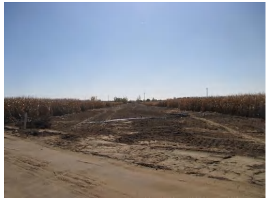
管线施工不设置弃土场、土壤全部用于管线沿线坑洼处平整使用
