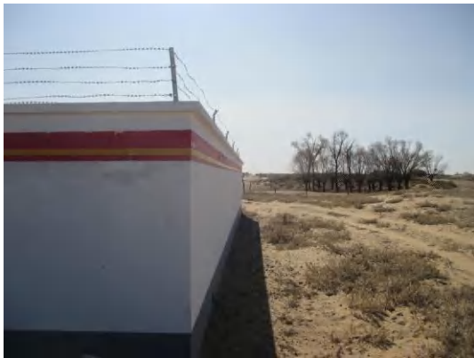
阀室外部自然恢复
