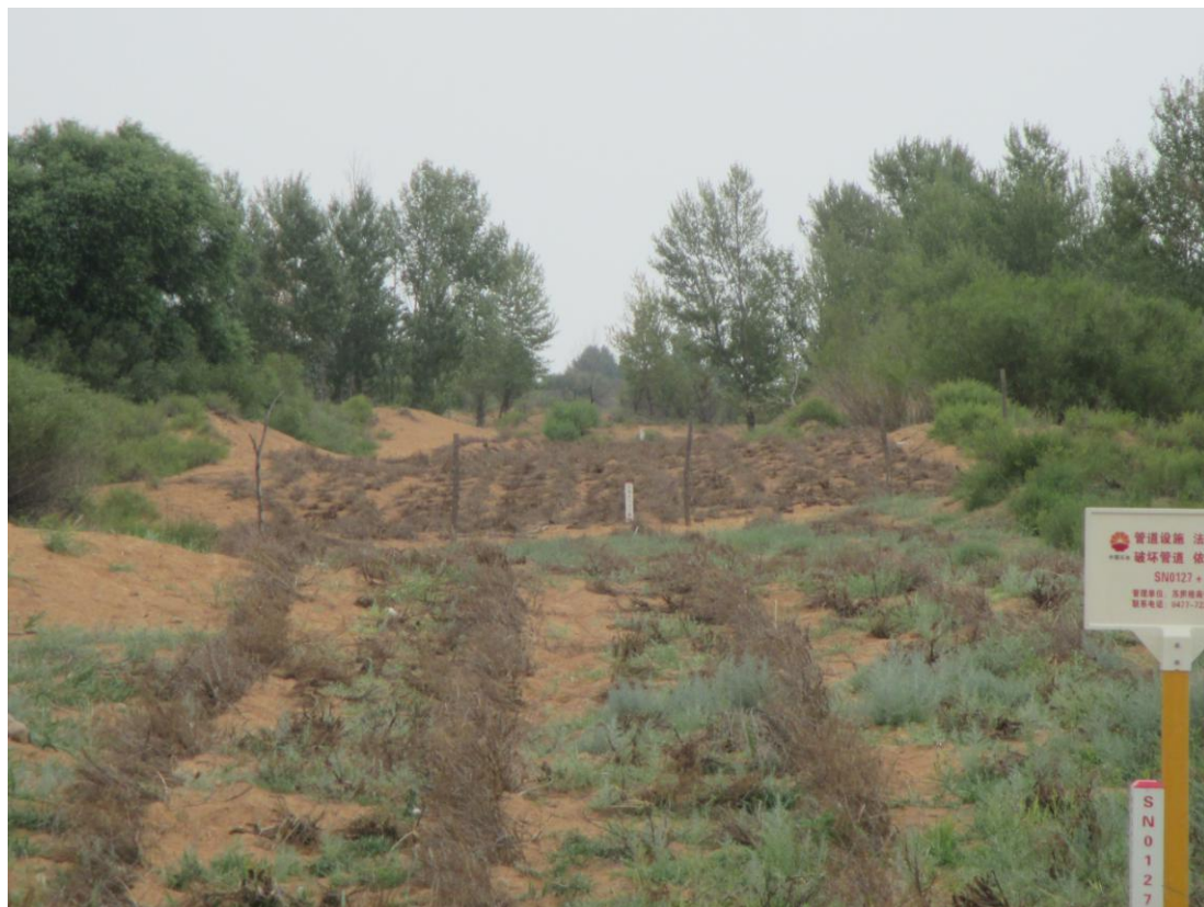
SN0127-05 管线作业带植被恢复
