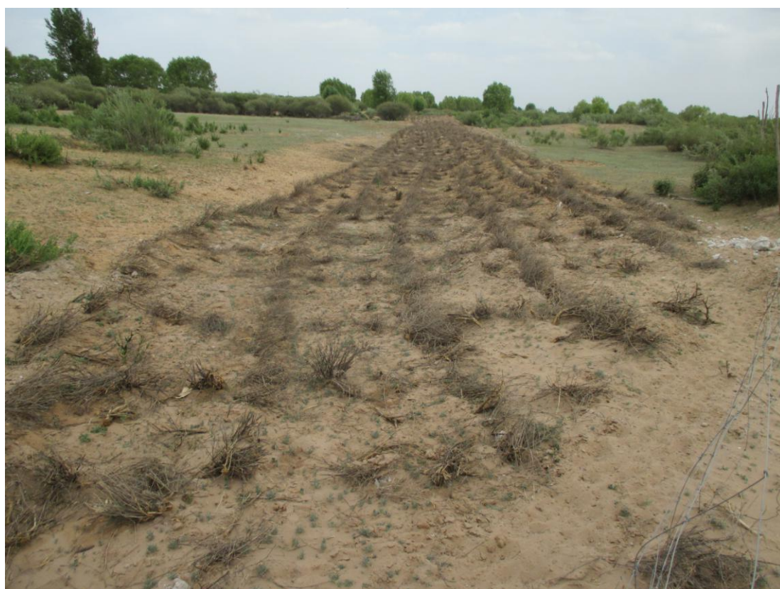
SN0101-05 管线作业带植被恢复
