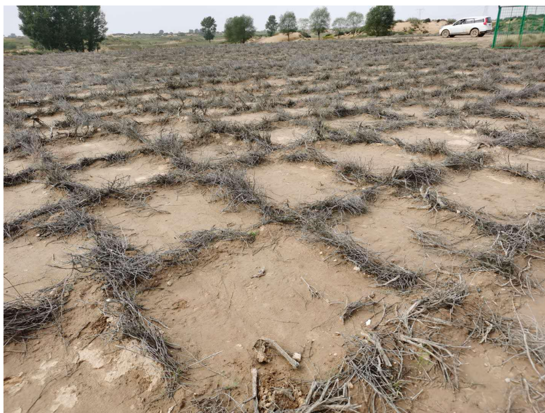
SN0128-05 管线作业带植被恢复
