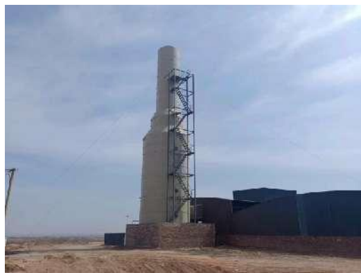
脱硫除尘塔+38.5m 排气筒
