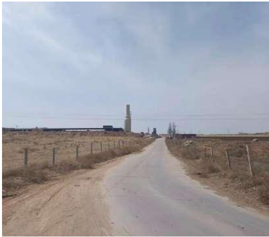
进厂道路硬化
