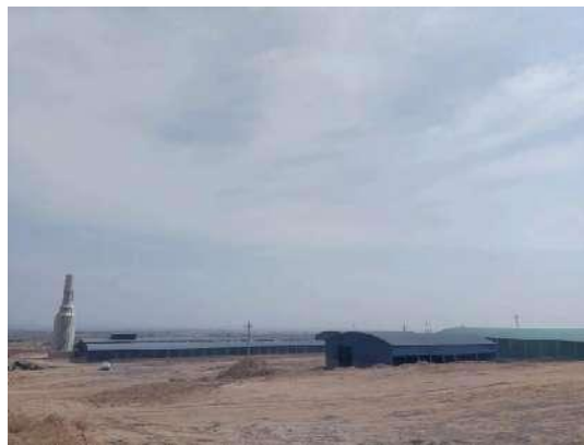
全封闭生产车间
