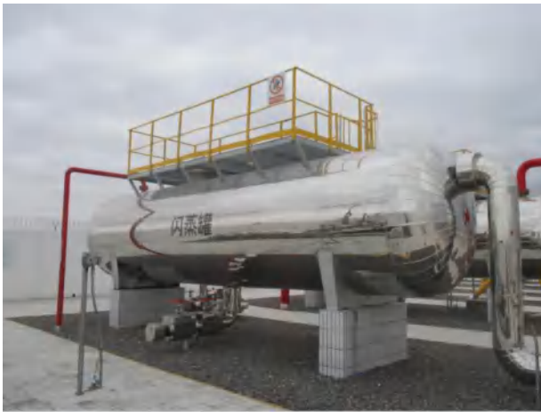
闪蒸罐和分液罐区
