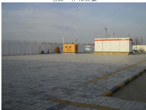
预留消防泵房、预留消防水罐区
