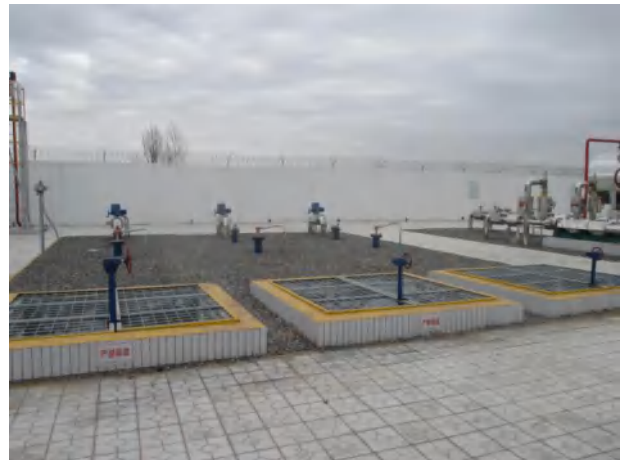
采出水罐区 (图左为阻火器)
