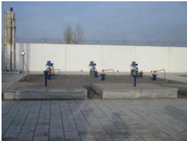
采出水罐区 (图左为阻火器)
