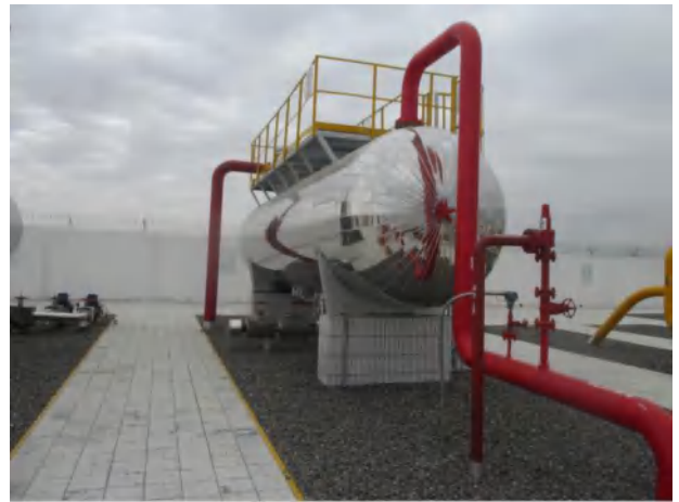
闪蒸罐和分液罐区
