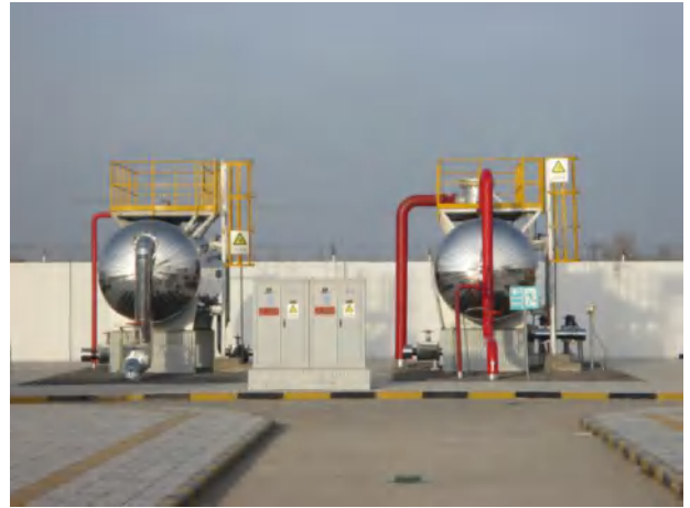
闪蒸罐和分液罐区
