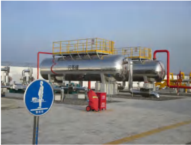
闪蒸罐和分液罐区
