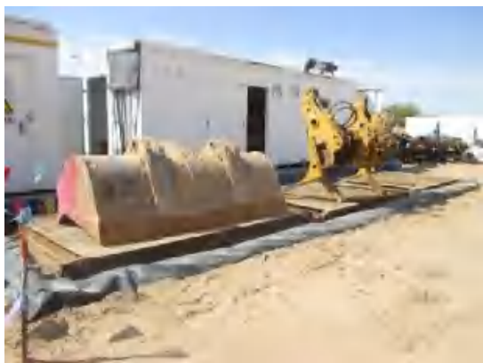
夹管器区防渗措施落实情况
