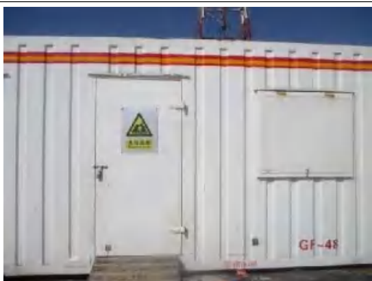
危险废物暂存间
