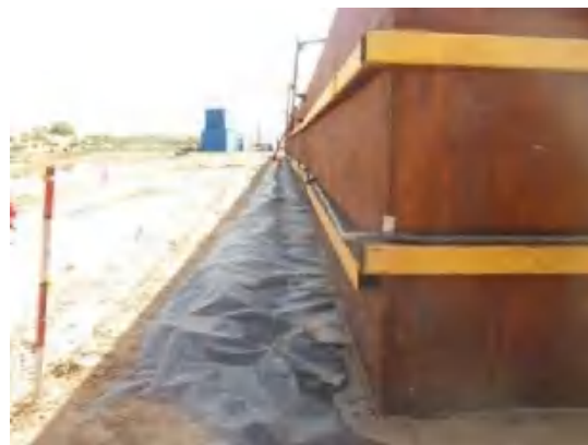
岩屑、泥浆罐区底部防渗落实情况
