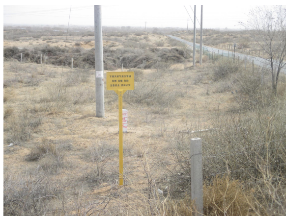
管线带上方设置标识标牌
