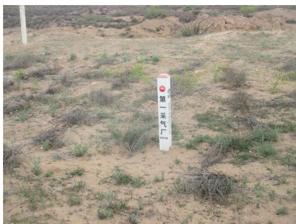
管线带上方设置标识标牌
