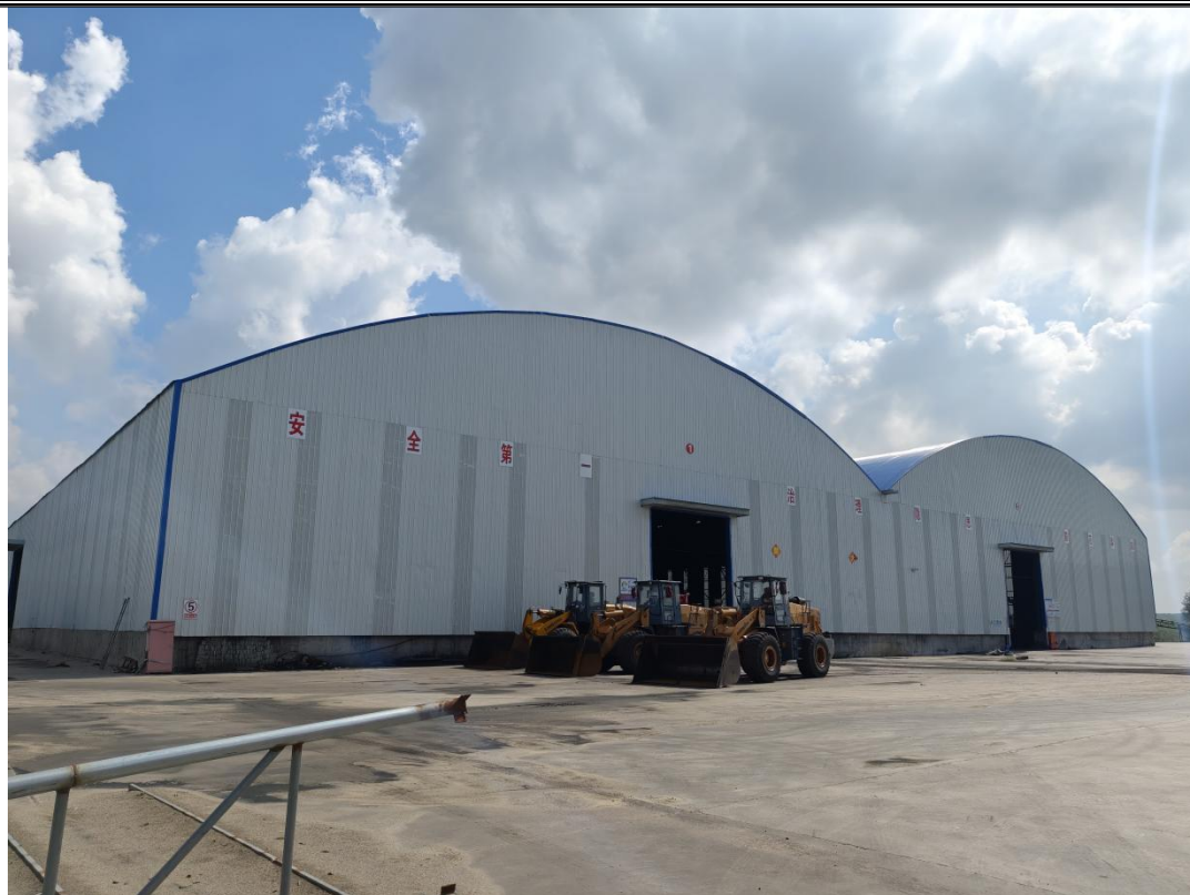
全封闭储煤棚
