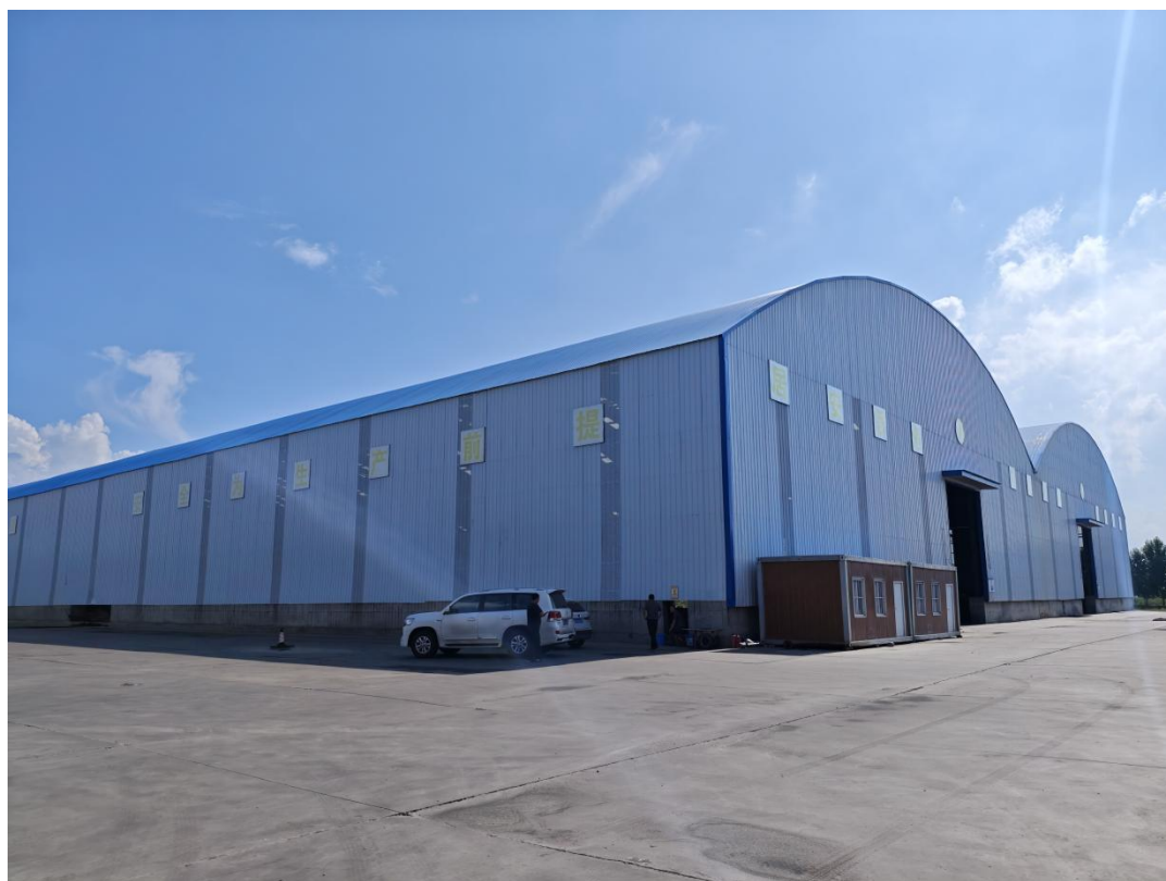
全封闭储煤棚
