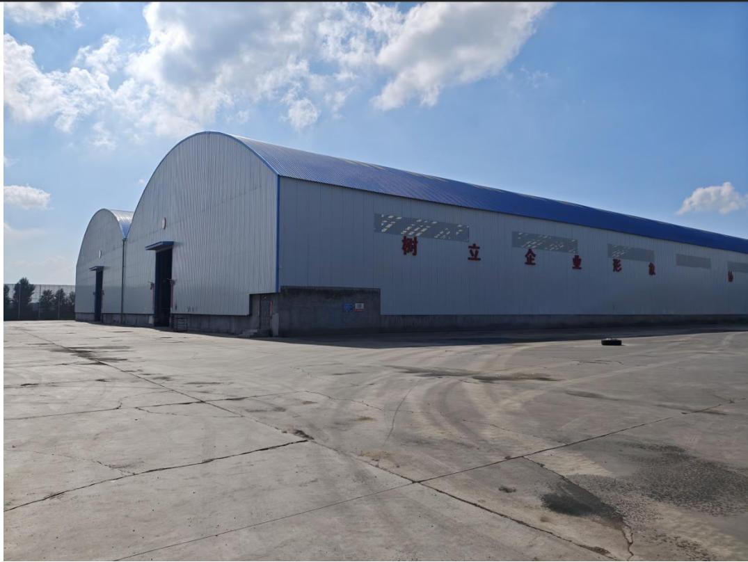
全封闭储煤棚
