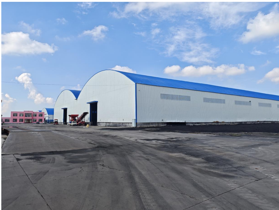
全封闭储煤棚
