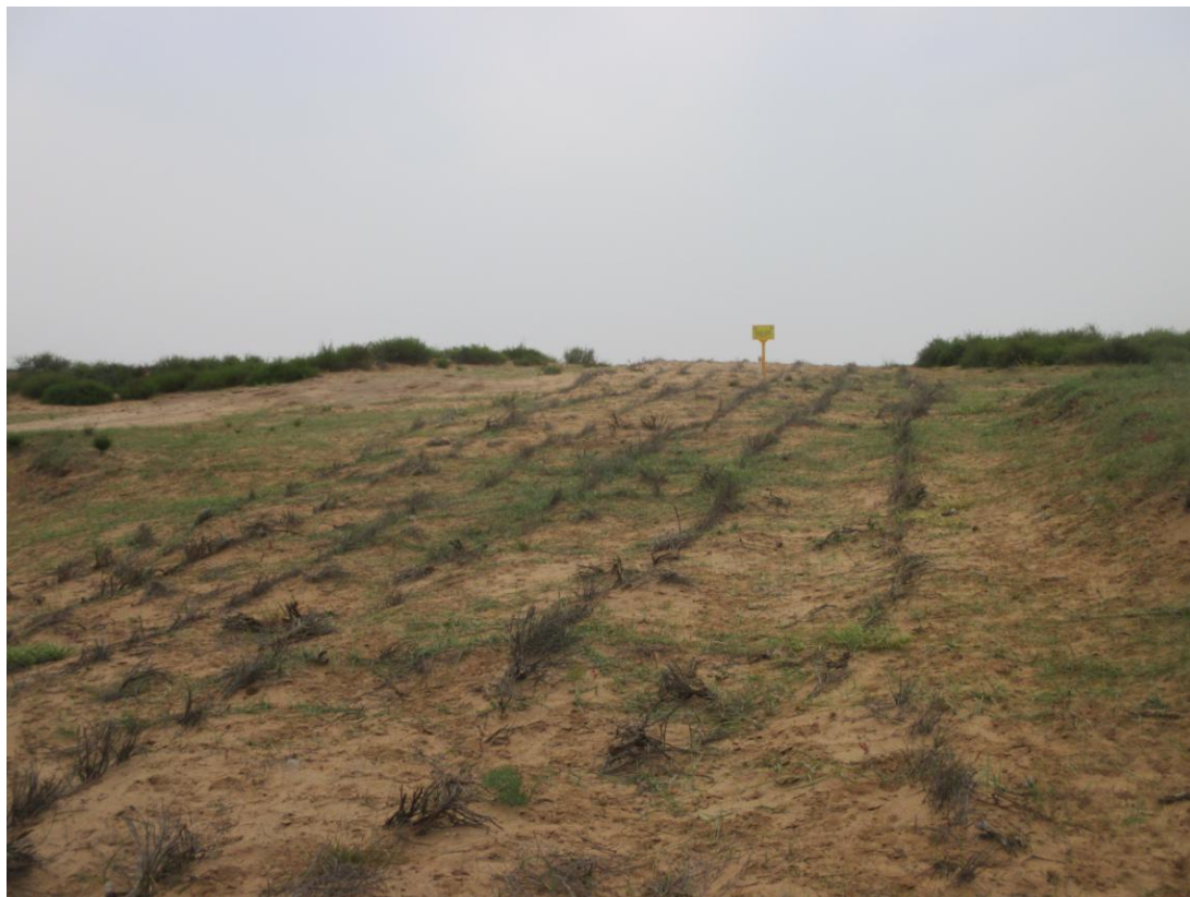
SN0063 管线作业带植被恢复
