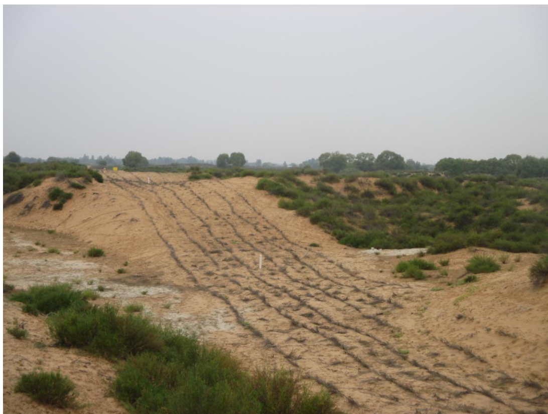
SN0063 管线作业带植被恢复
