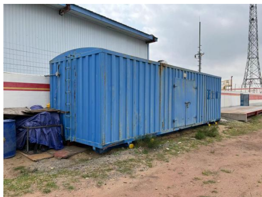
危废暂存库房外部
