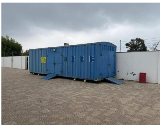
危废暂存库房外部
