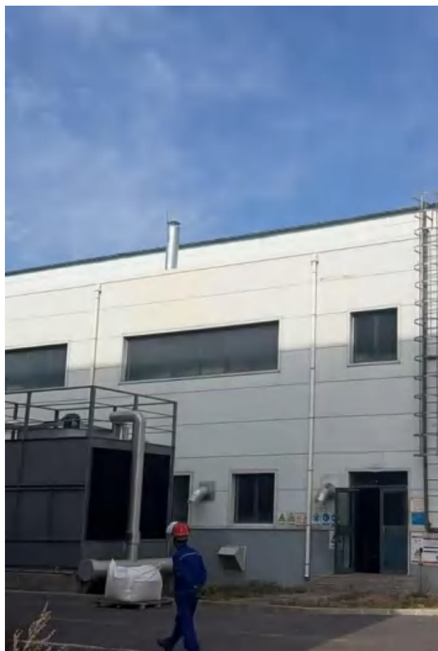
抽真空废气排气筒 DA004
