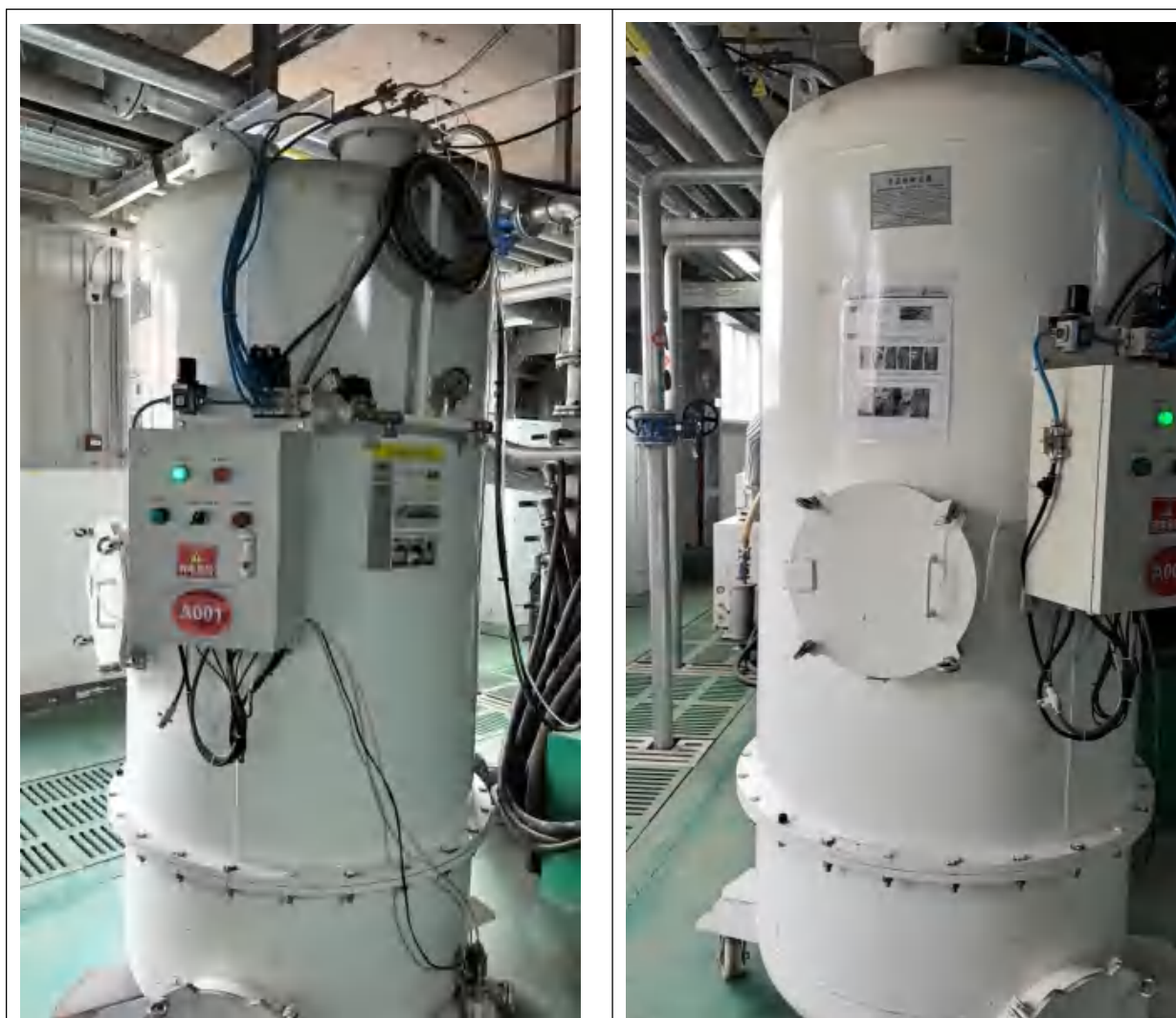
单晶炉自带滤芯除尘器
