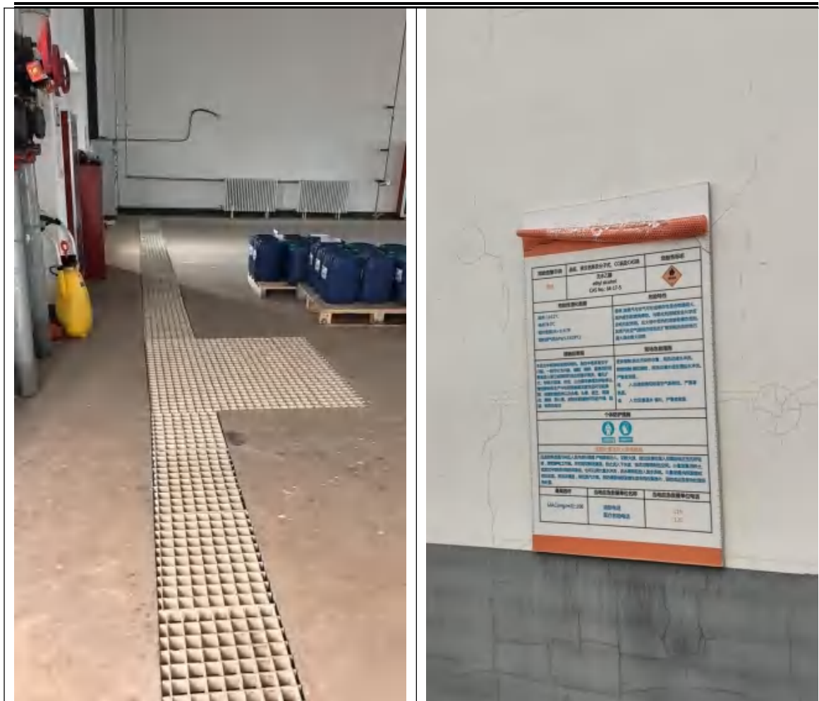
危险废物暂存库
