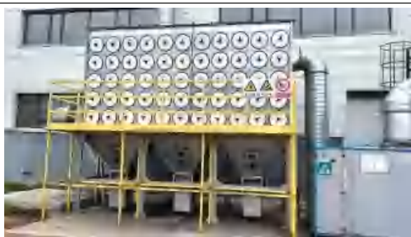
装料废气风机及除尘器
