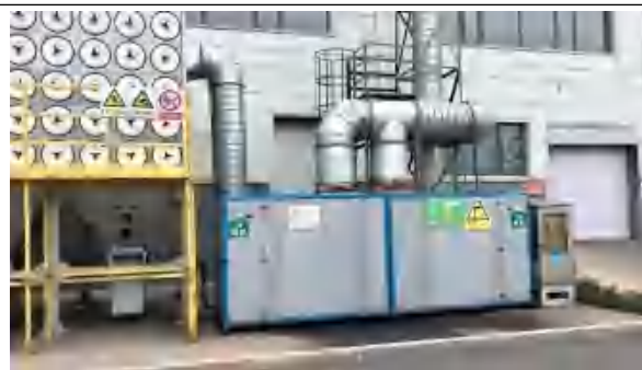
装料废气风机及除尘器
