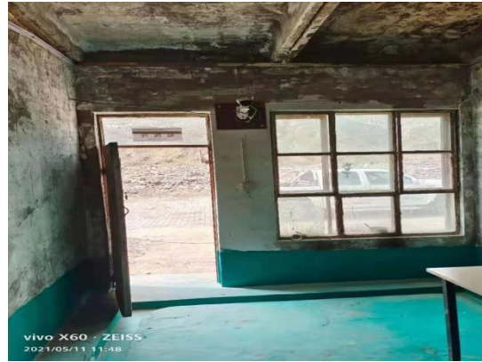
危险废物贮存库摄像头
