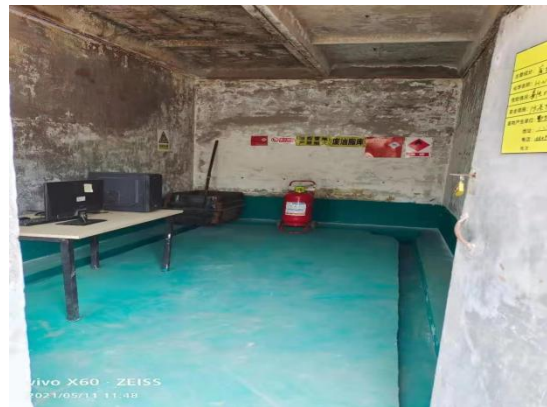
危险废物贮存库防渗线
