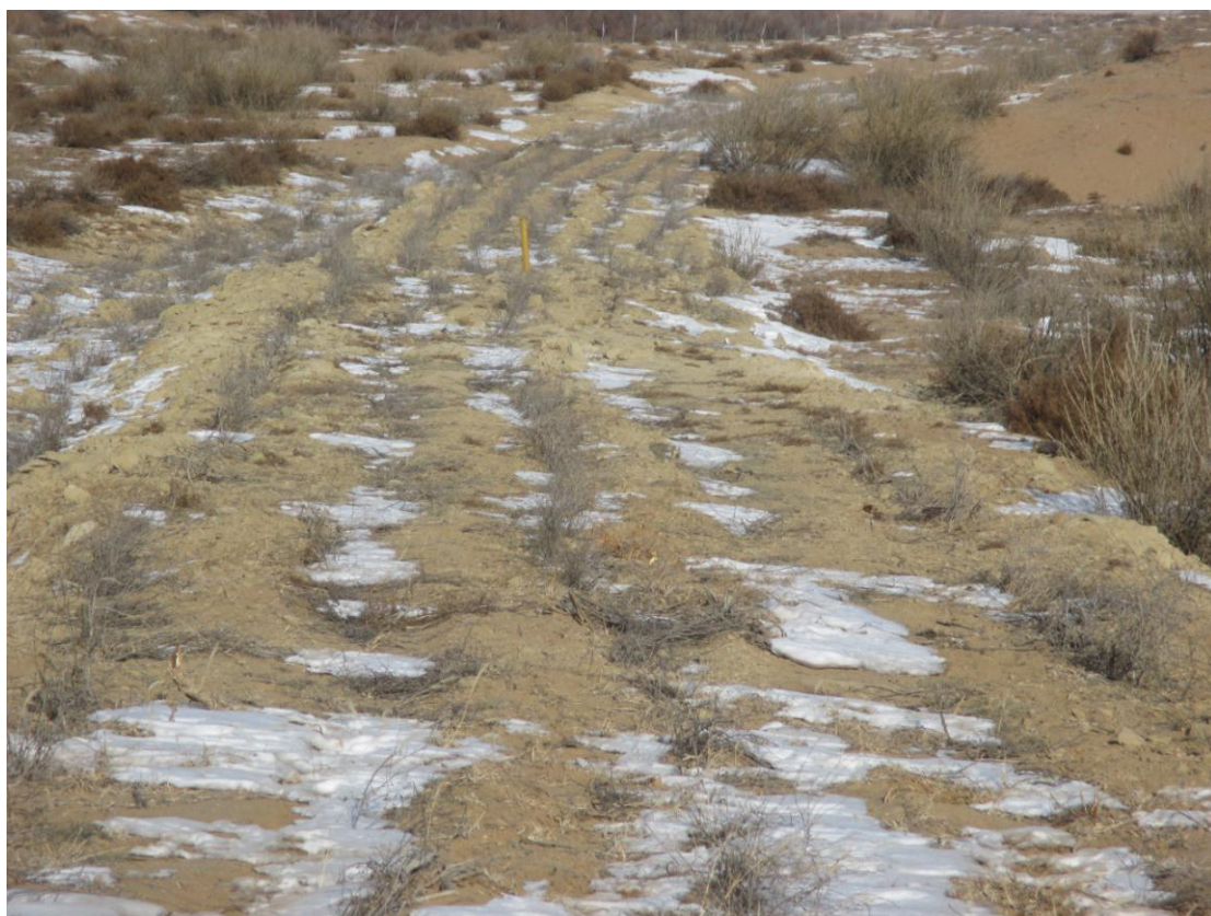
管线植被恢复情况
