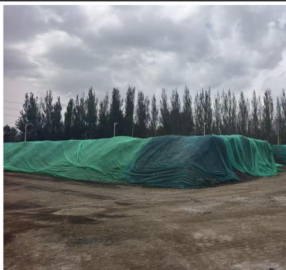
产品苫盖措施
