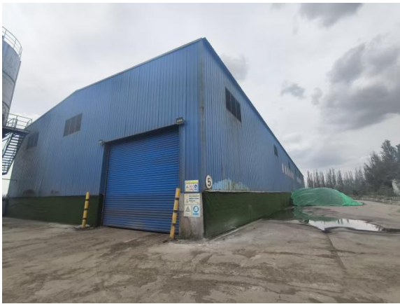
2250m 2 全封闭原料储棚
