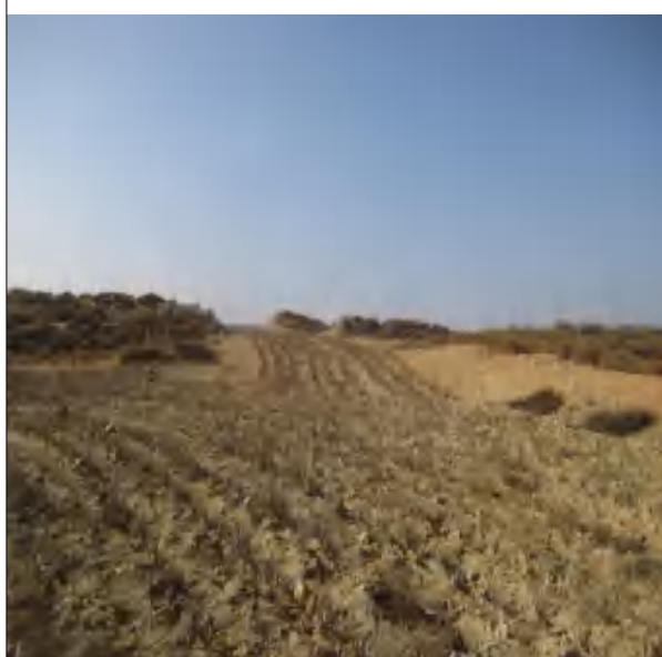
管线临时占地植被恢复
