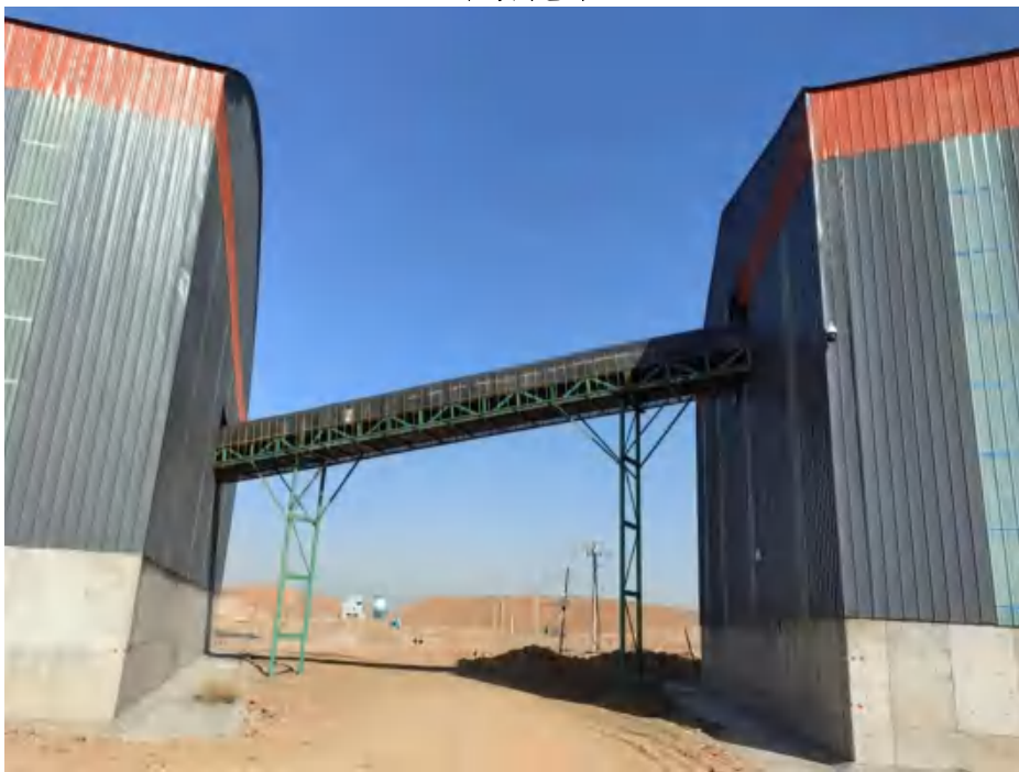
全封闭输煤栈道
