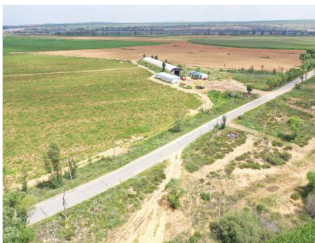
管线顶管穿越混凝土路
