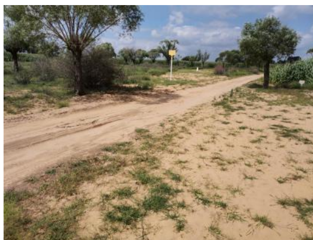
管线穿越土路采用大开挖方式
