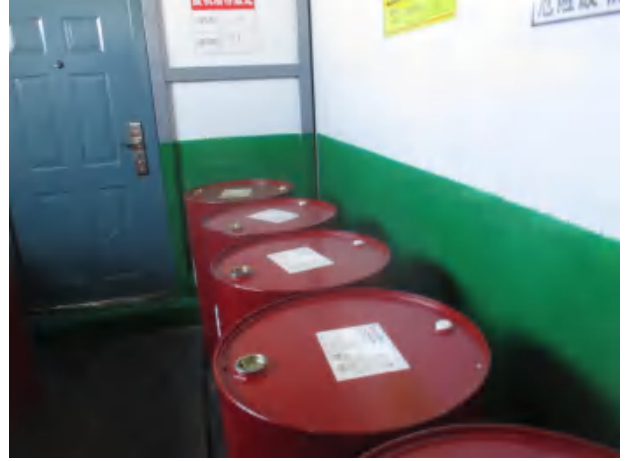
危废库地面及裙角 1.2m 高涂刷环氧树脂地坪漆
