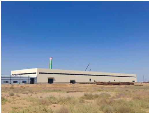
全封闭车间和 25 米排气筒
