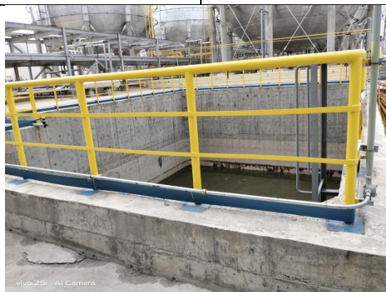
罐区东侧初期雨水收集池
