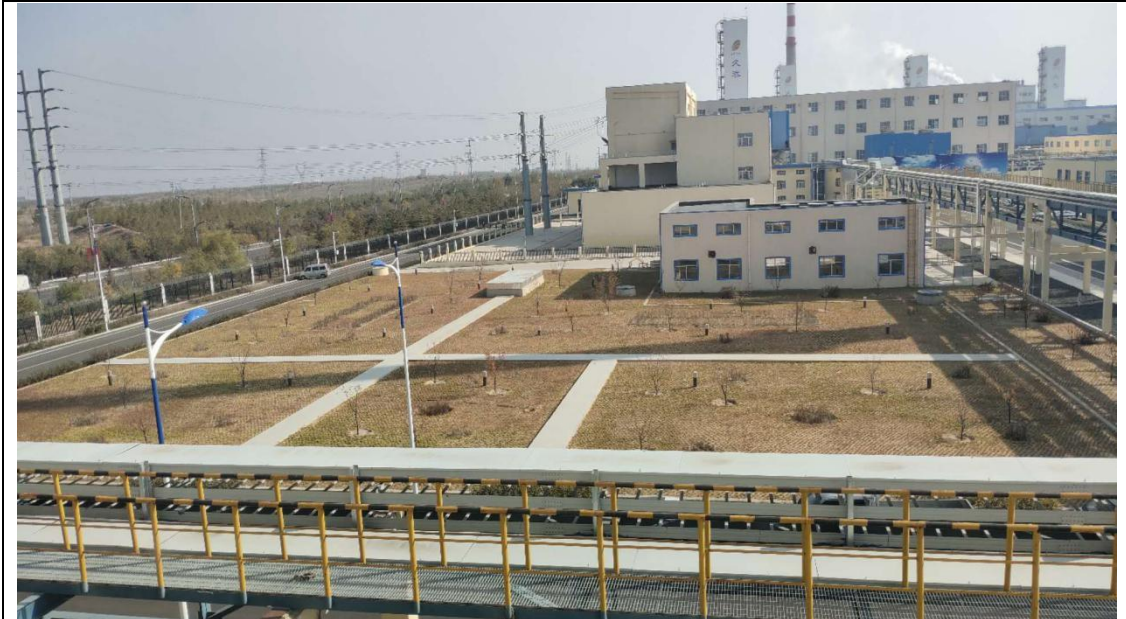
依托“甲醇深加工项目”厂区内设置的一座 20000m 3 的全厂事故废水收集池
