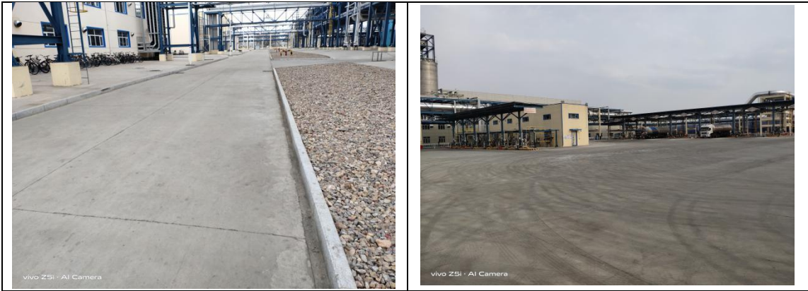
道路及厂区硬化
