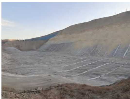
填埋场底部铺设防渗膜
