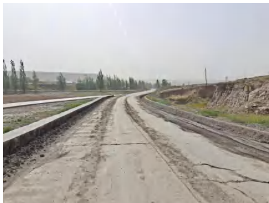
进场道路硬化
