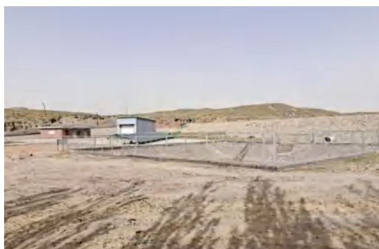
渗滤液收集池
