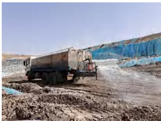
填埋场洒水降尘
