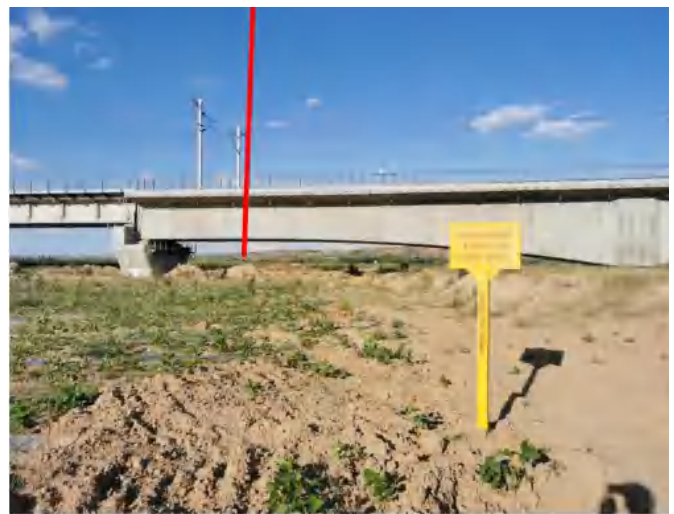
管线大开挖穿越土路
