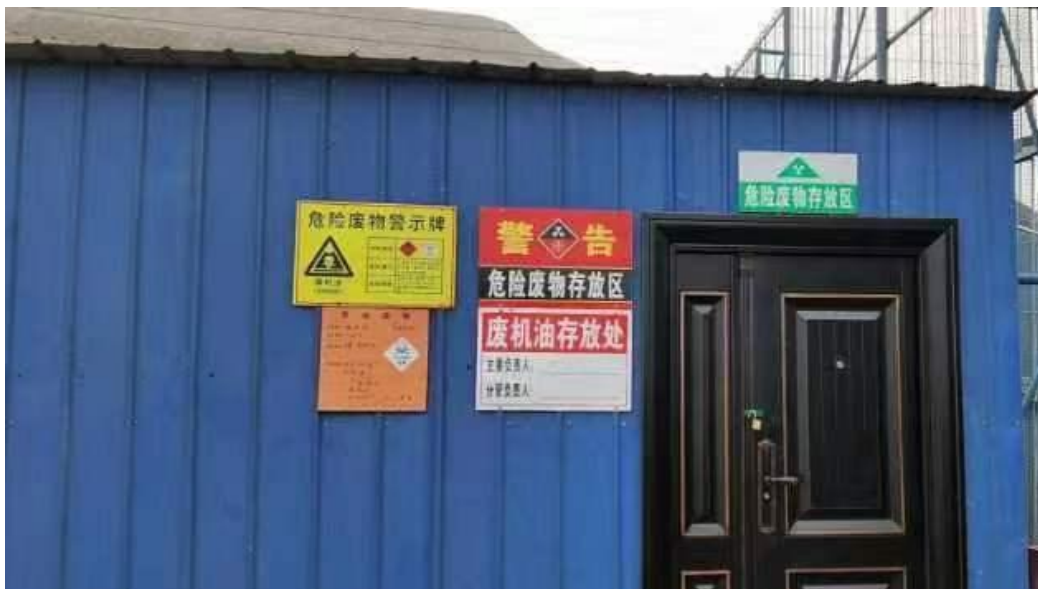
危废库房外部
