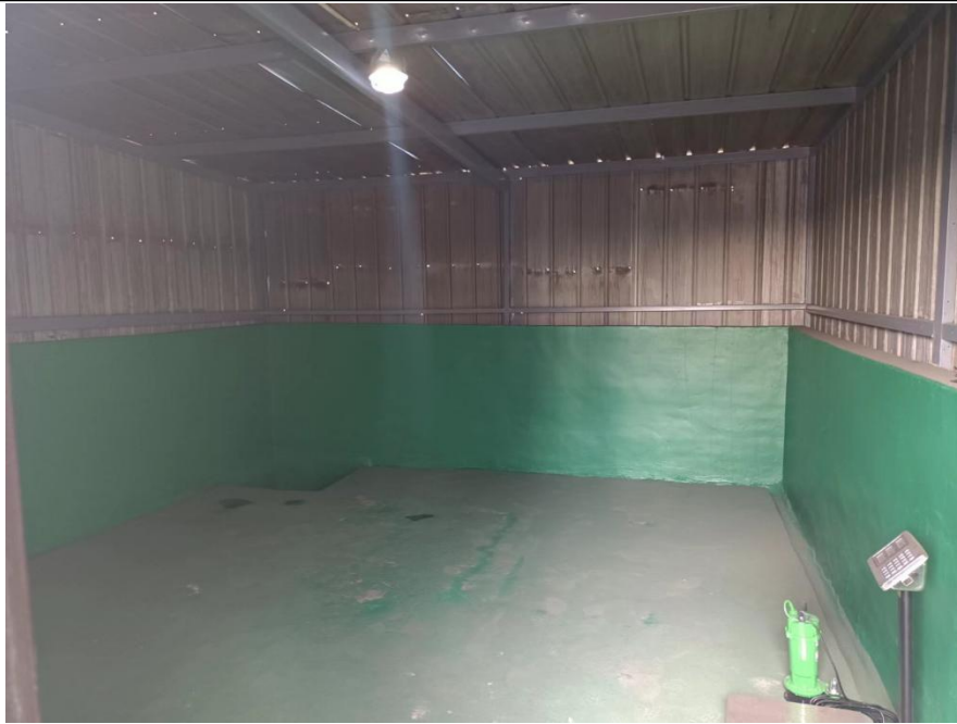
危废库房内部
