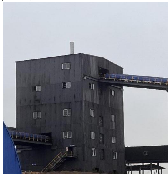
全封闭筛分楼及 16m 高排气筒
