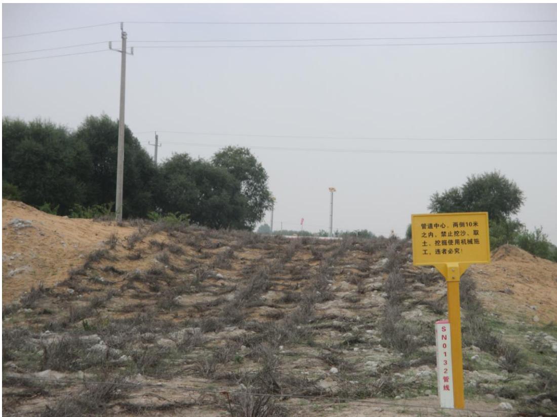
SN0132 管线植被恢复情况
