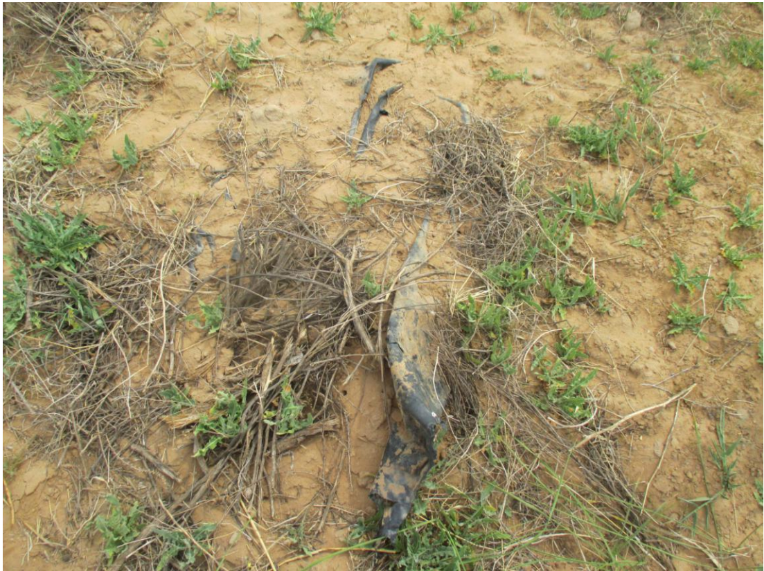
SN0101（1）管线植被恢复情况
