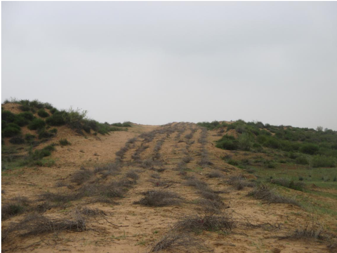
SN0150 管线作业带植被恢复
