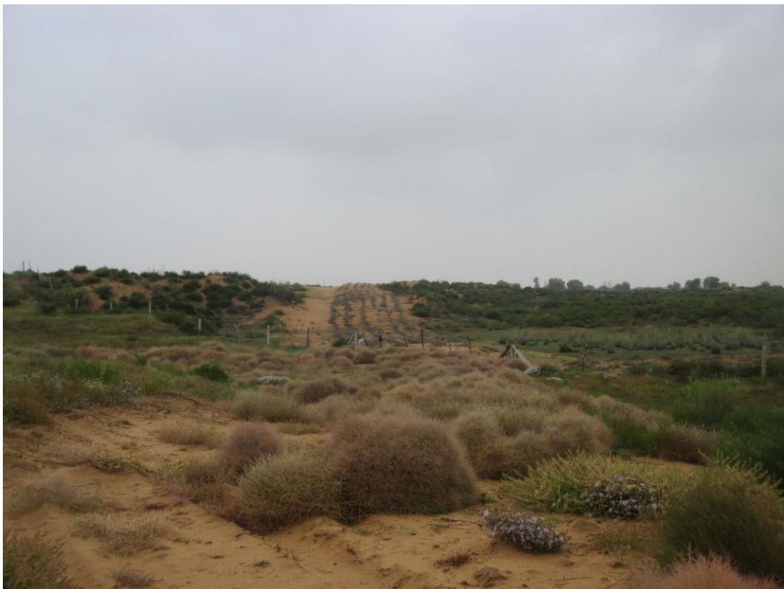
SN0150 管线作业带植被恢复
