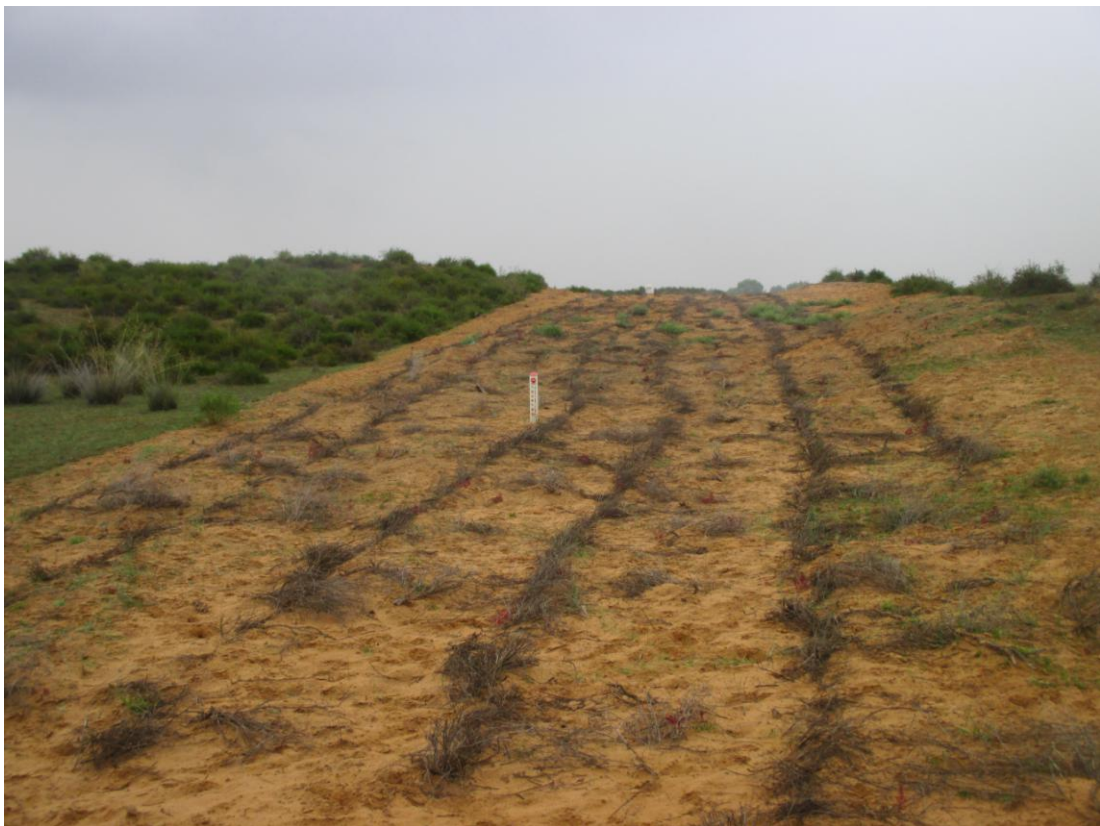
SN0150 管线作业带植被恢复
