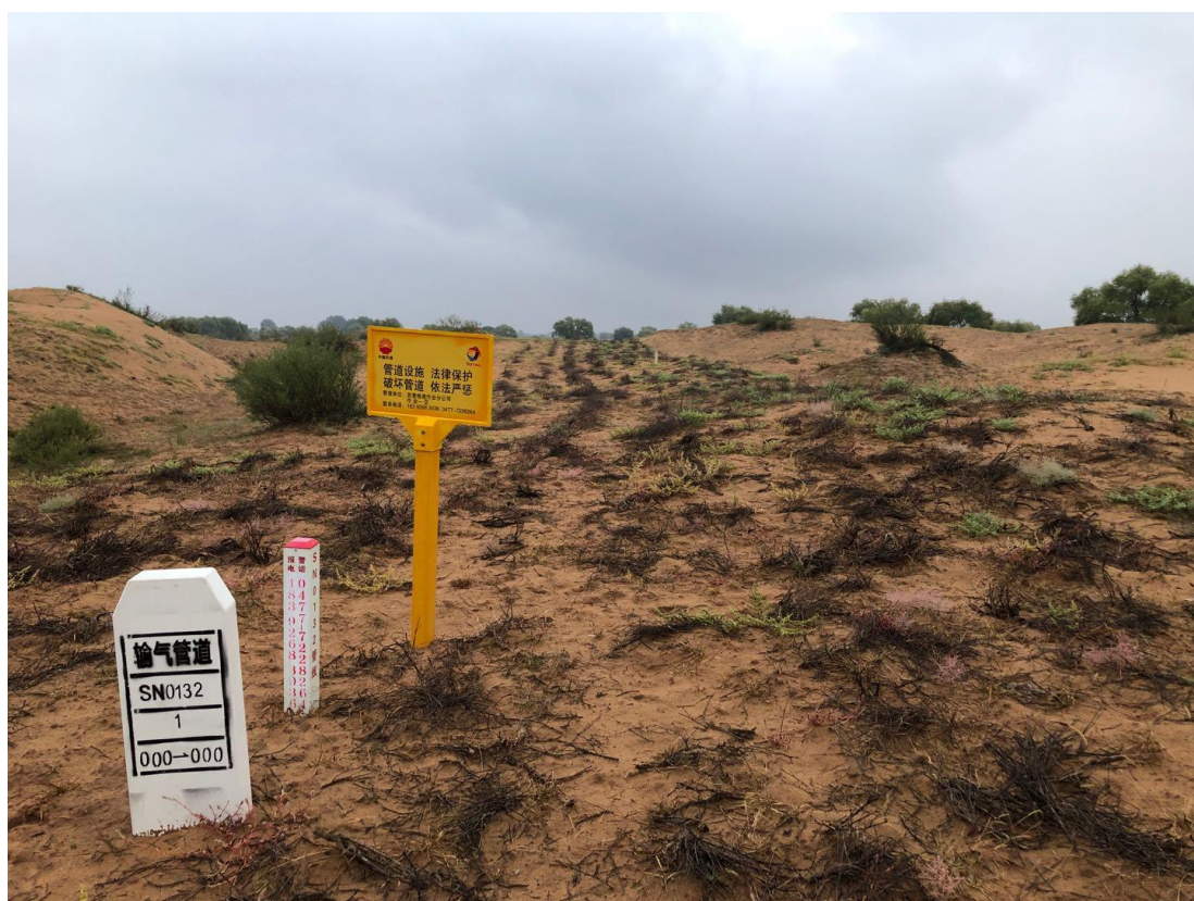
SN0132 管线植被恢复情况
