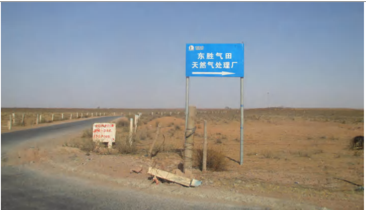
新建东胜气田集中处理站进站道路
