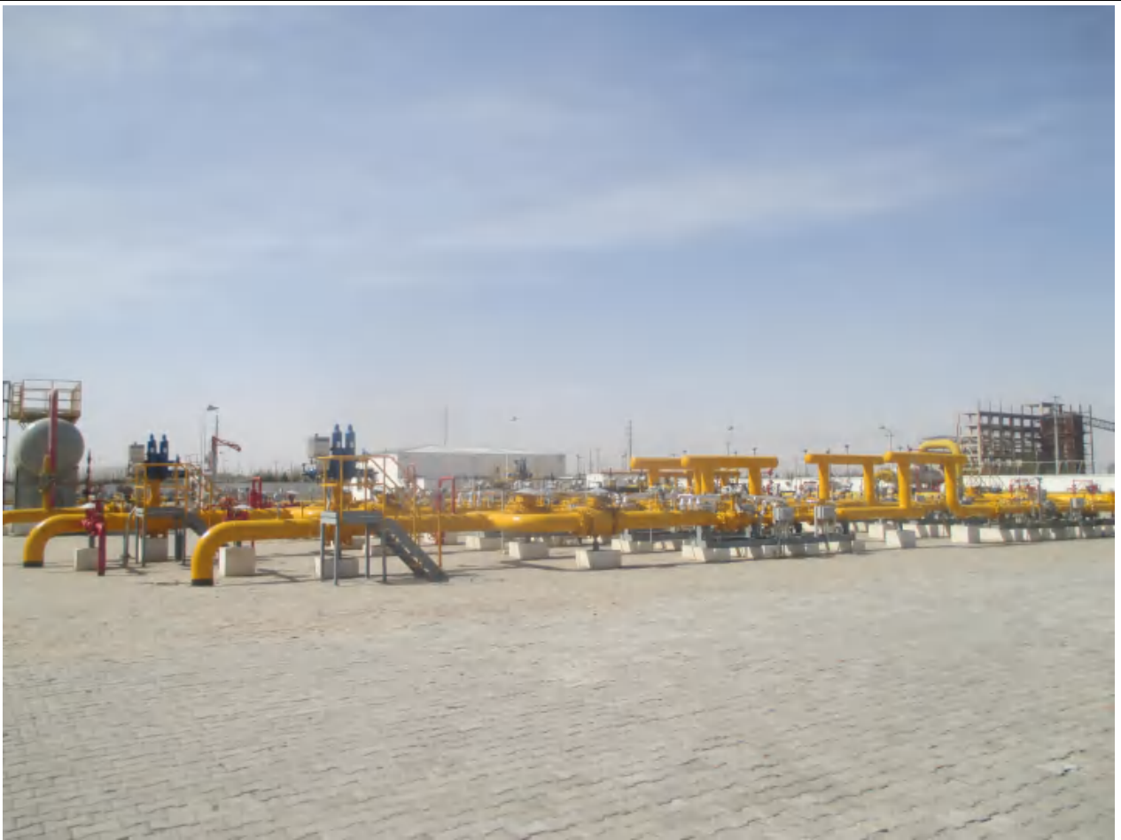
对站内大杭管道进行计量改造，实现正反输计量
