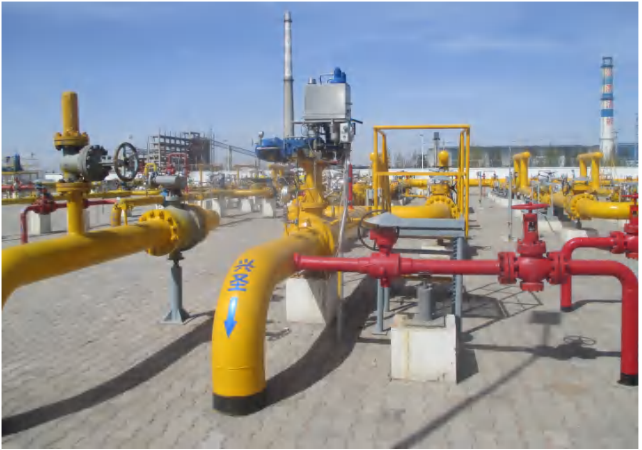
新增兴圣分输计量系统，输气能力为 7.88 \times 10^8 \text{m}^3/\text{a}
