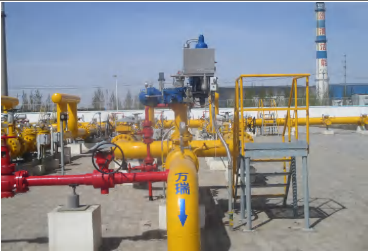
新增万瑞分输计量系统，输气能力为 4.3 \times 10^8 \text{m}^3/\text{a}
