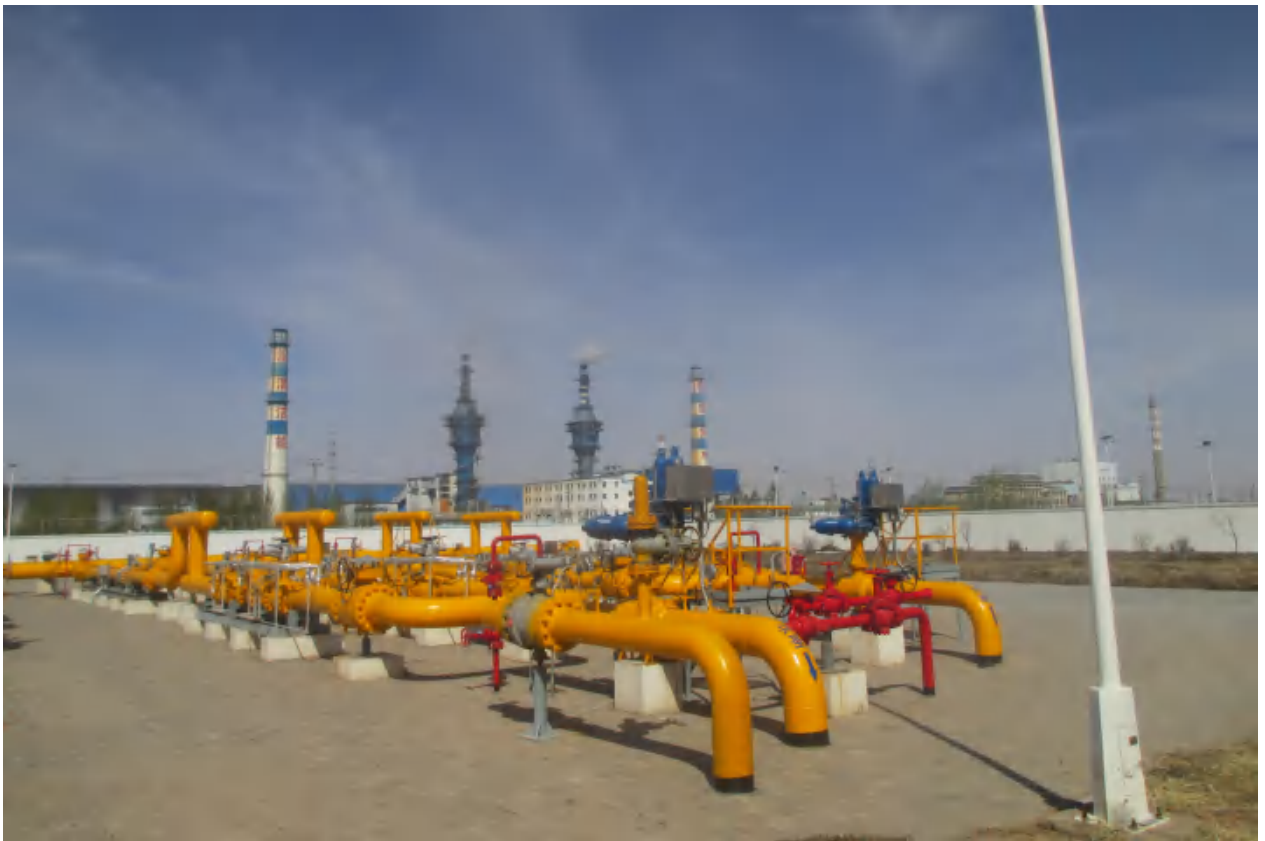
改造原兴圣分输计量支路，作为下游亨东用户的备用计量支路
