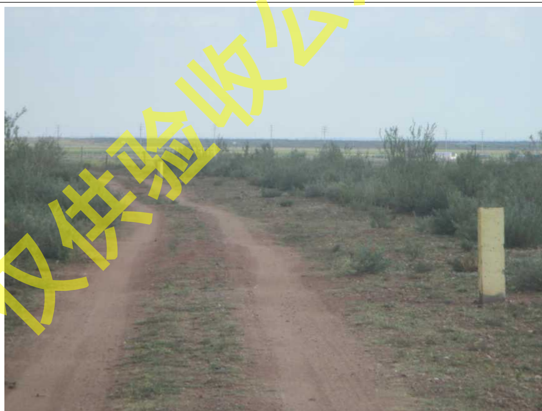
管线植被恢复
