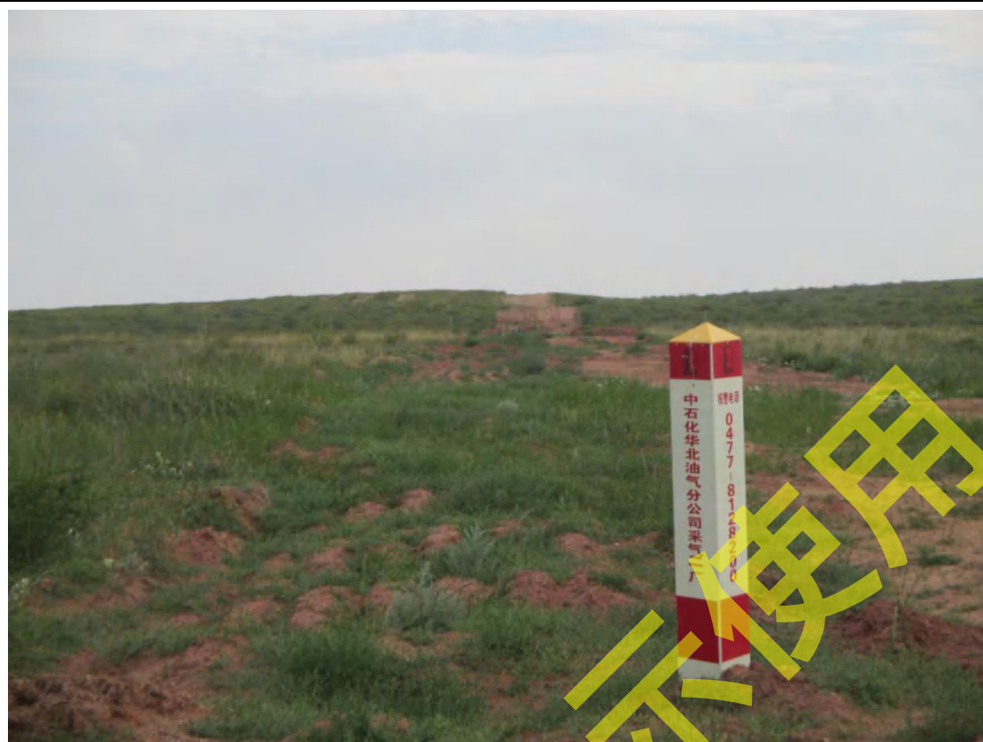
管线植被恢复
