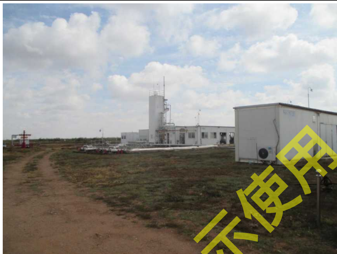
井场回收气作业
