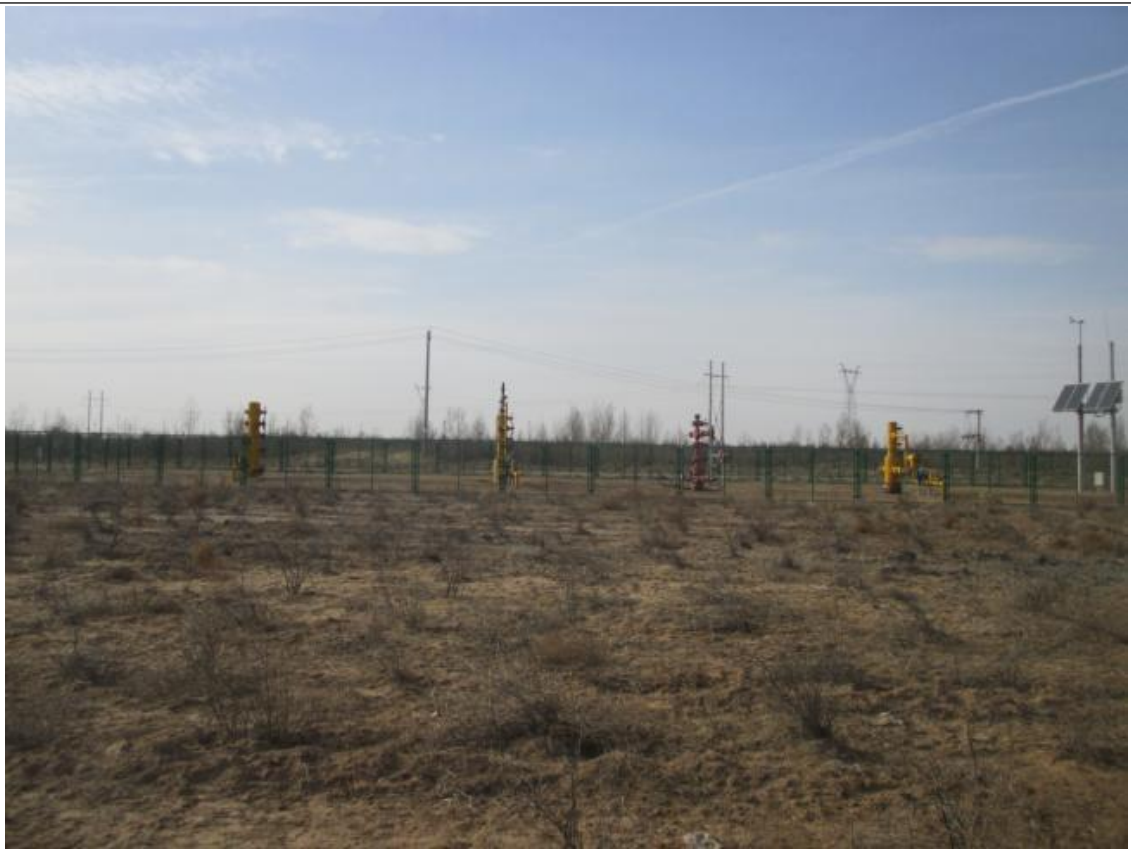
井场植被恢复情况
