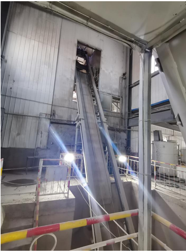
全封闭彩钢搅拌楼输送廊道
