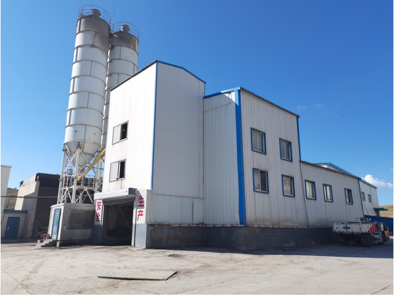
全封闭搅拌楼
