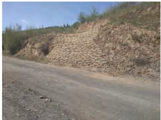
管线大开挖穿越土路
