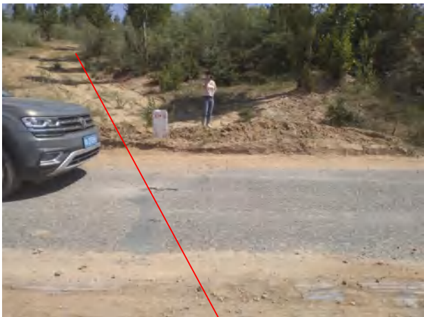
管线顶管穿越沥青路
