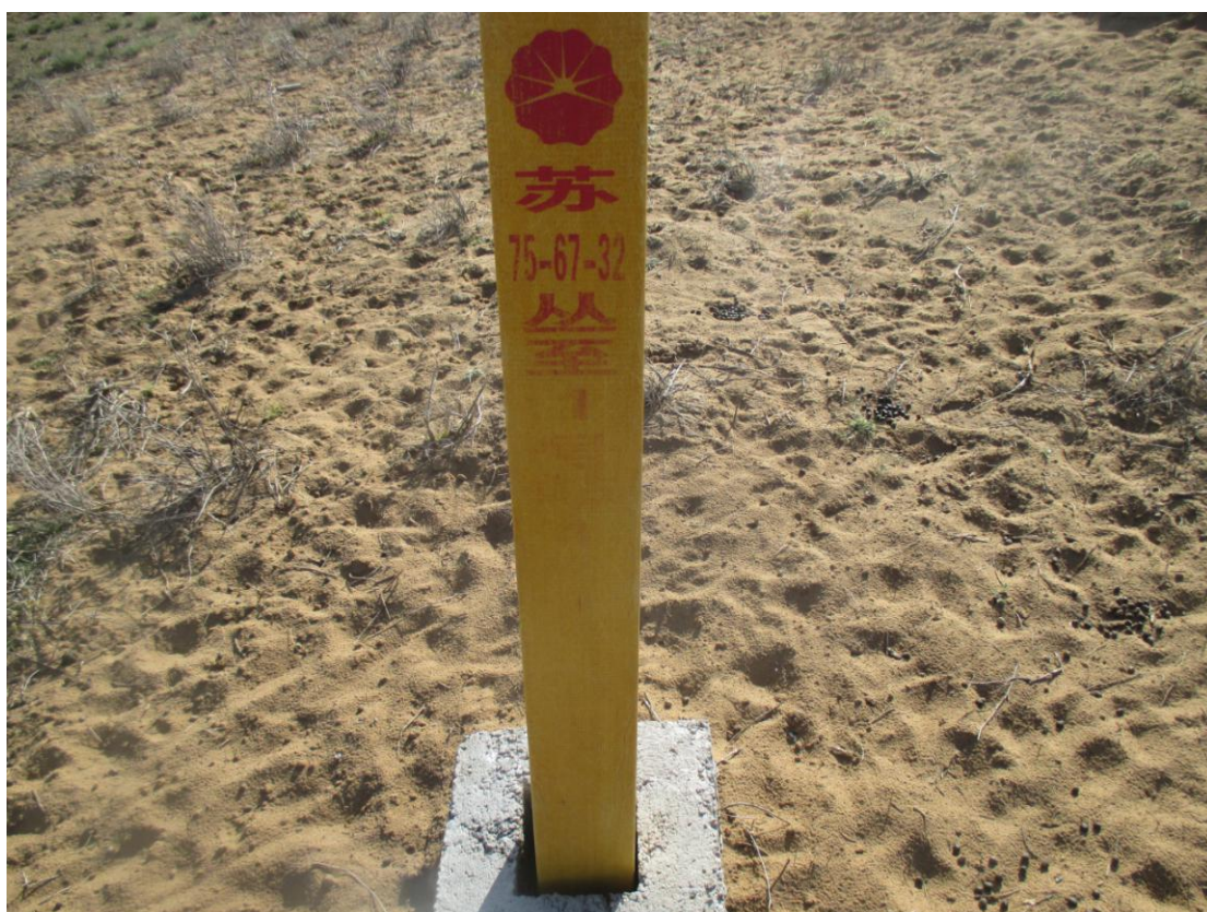
苏 75-67-32 接入苏 75-1 号集气站 4 号干管植被恢复情况
