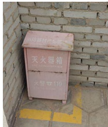
危废暂存库应急消防设施
