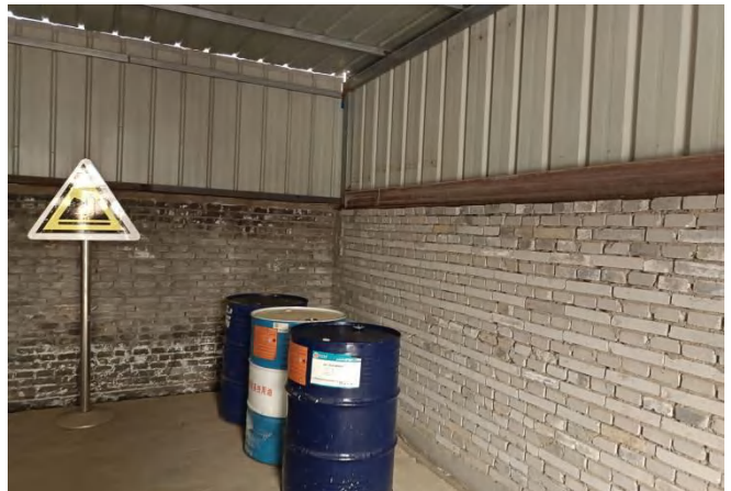
危废暂存库内部
