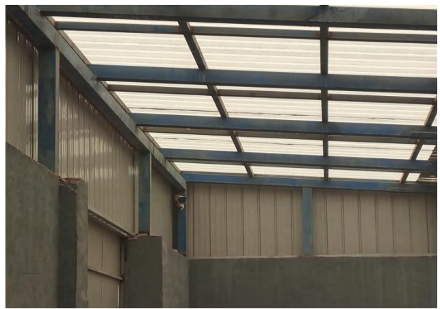
甲氨基危废暂存库监控设施
