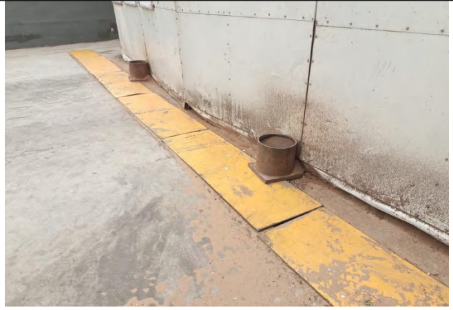
一期废菌丝暂存库防雨水导流槽
