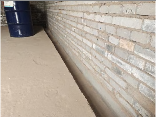
危废暂存库导流槽
