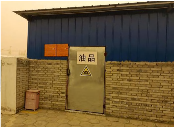
危废暂存库外部
