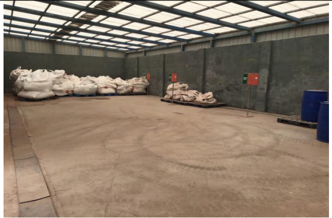
甲氨基危废暂存库内部
