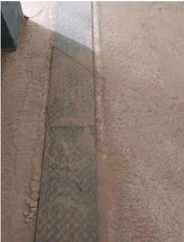
甲氨基危废暂存库导流槽
