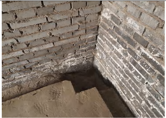
危废暂存库收集池
