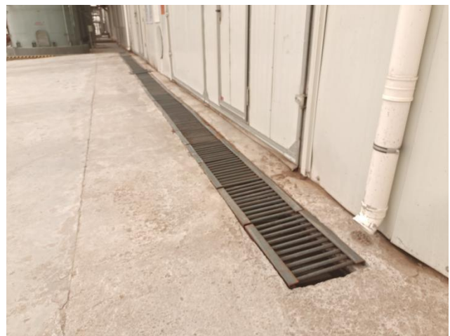
二期废菌丝暂存库防雨水导流槽
