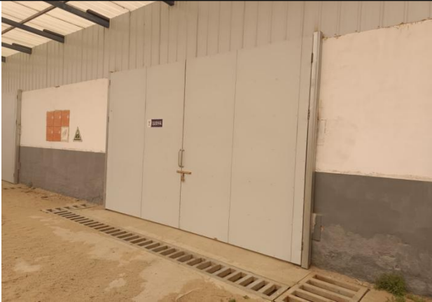
甲氨基危废暂存库外部
