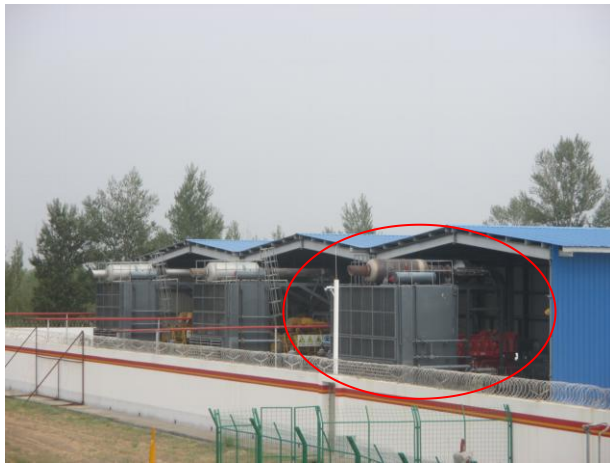
新建压缩机 1 台
