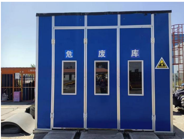
全封闭危废暂存库
