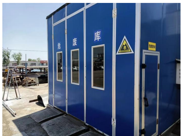
危废暂存库外部
