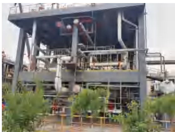
新增 4 套转换器、转化冷剂冷凝器和转化器冷剂液位罐
