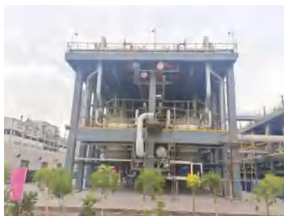
新增 4 套转换器、转化冷剂冷凝器和转化器冷剂液位罐
