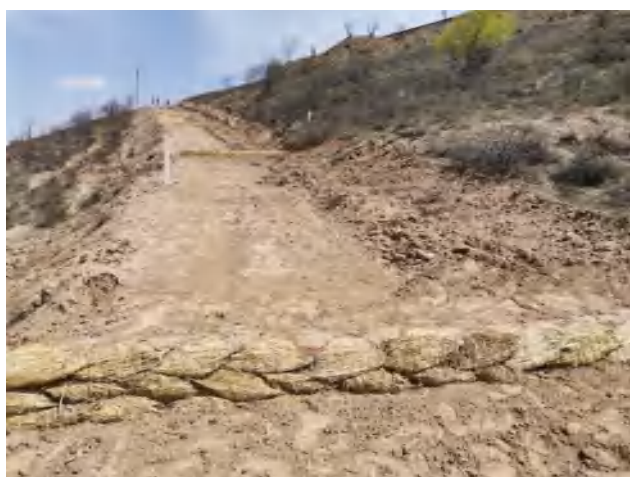
管线作业带沿线设置的草袋挡水坎
