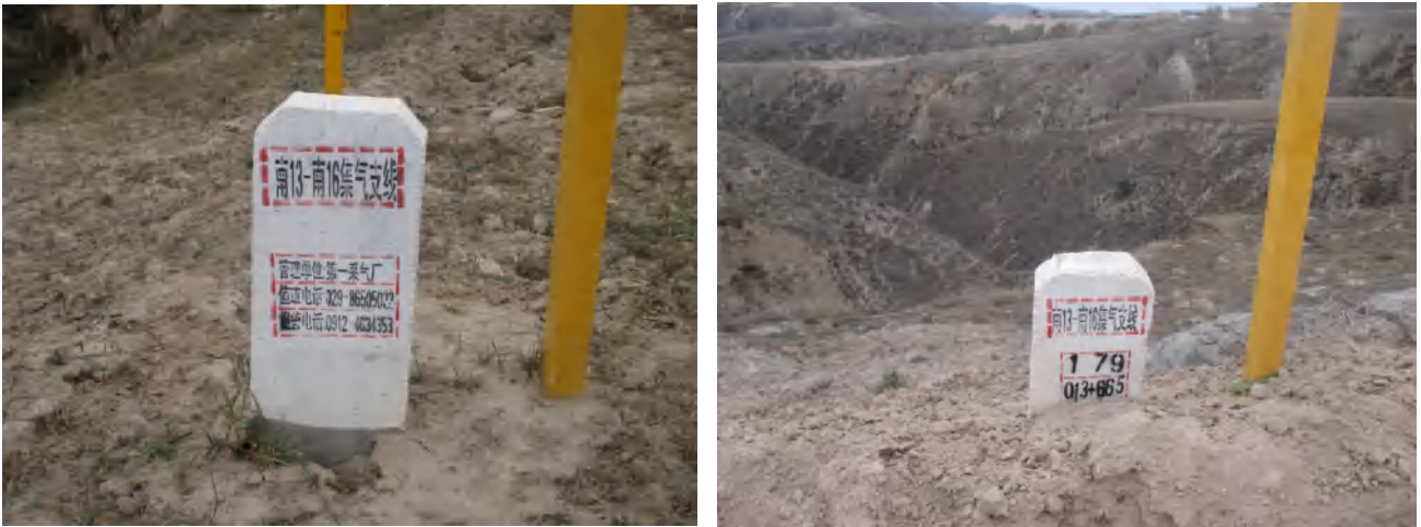
管线里程桩及加密标识桩、标识标牌
