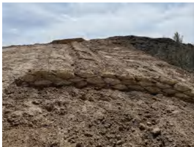
管线作业带沿线设置的草袋挡水坎
