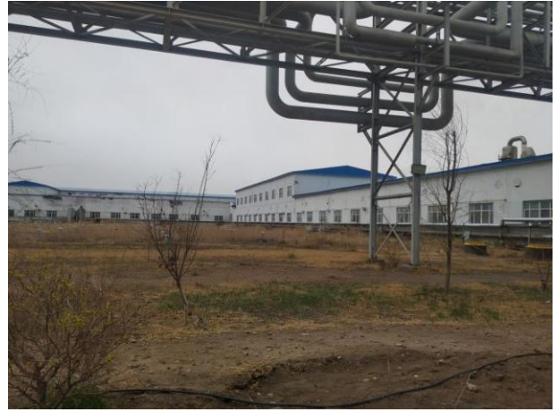
污水处理站（依托）
