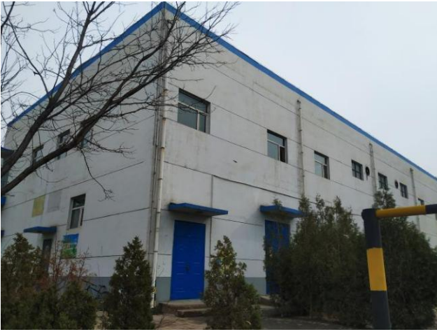
35Kv 变电站（依托）
