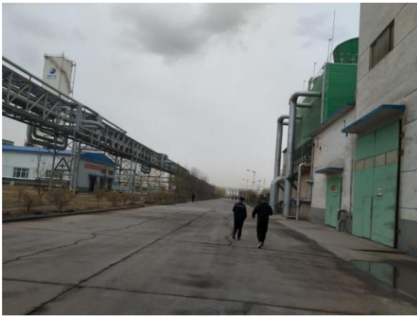
项目南侧道路
