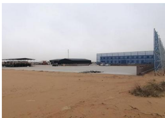
岩屑堆场硬化+10m 防风抑尘网
