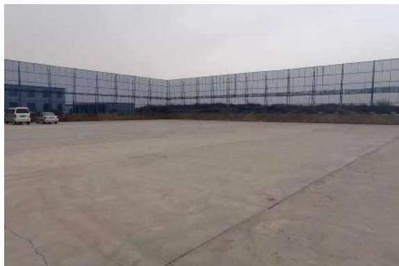
岩屑堆场硬化+10m 防风抑尘网
