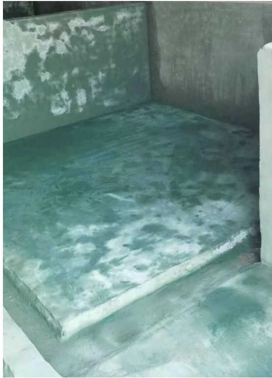
危废库导流槽
