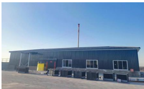
全封闭深度处理车间
