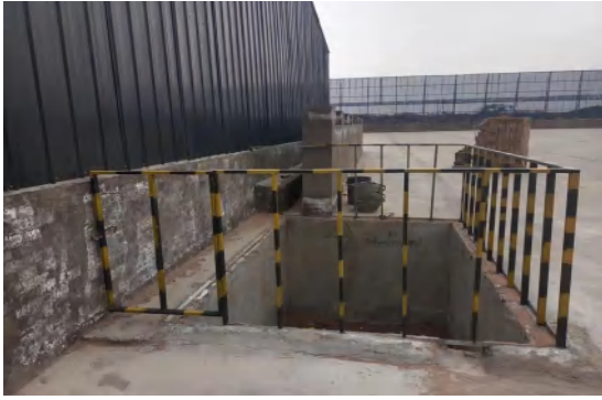
初期雨水收集池
